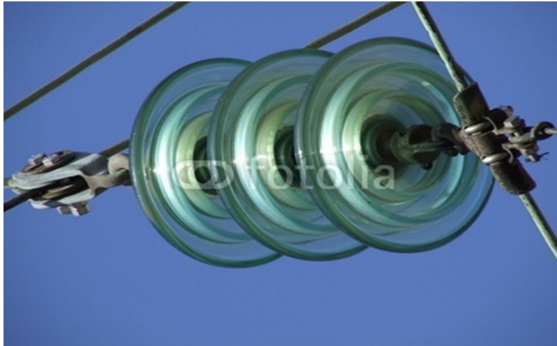
Figure (1.11) : Photo d'un isolateur.
