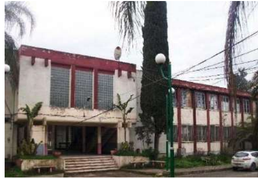
Figure III.3.28: Façade principale du bloc A.
