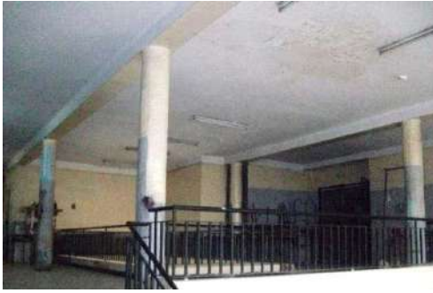
Figure III.3.30: Structure apparente de la mezzanine du bloc A Source : auteurs
