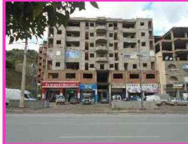
Figure III.3.9 : Immeuble collectif en construction au Nord, R+6
