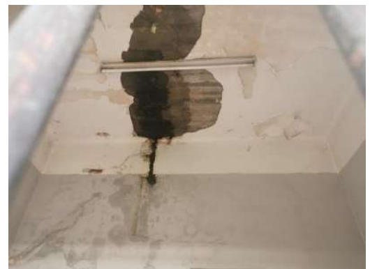
FigureIII.3.40: Vue sur le faux plafond de l'amphithéâtre Source :auteurs
