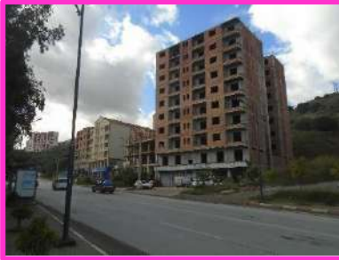
Figure III.3.8: Immeuble collectif en construction au Nord, R+9
