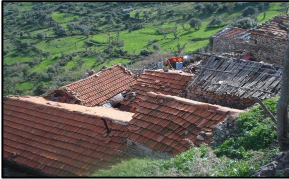
Figure84 : usage de la tuile dans la couverture d'une maison kabyle Source : Google image.
