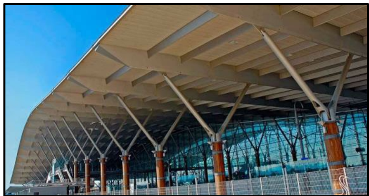
Figure194 : Structure lamellé collé
