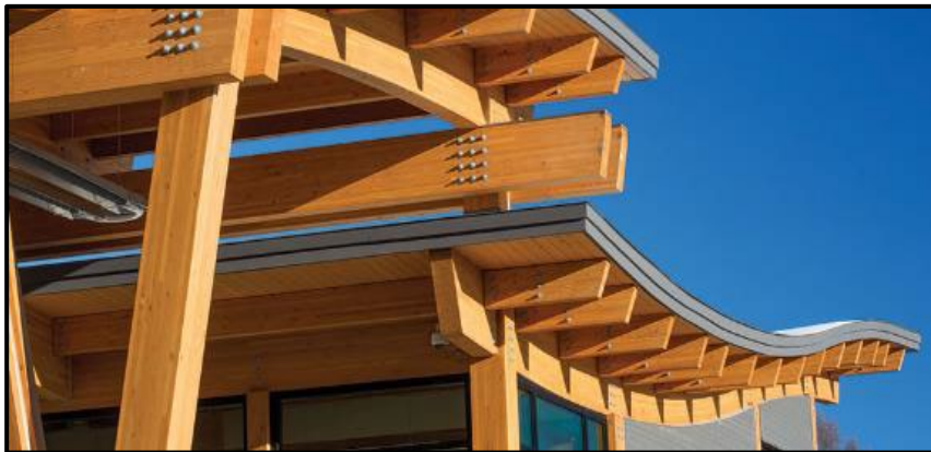
Figure201: Poutre en bois lamellé collé Source : cecobois.com
