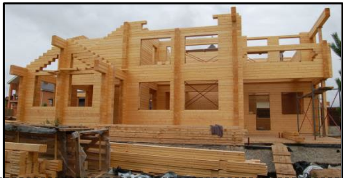
Figure196 : fabrication de poutres en bois lamellé collé
