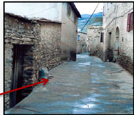
Figure75 : rue principale d'un village
