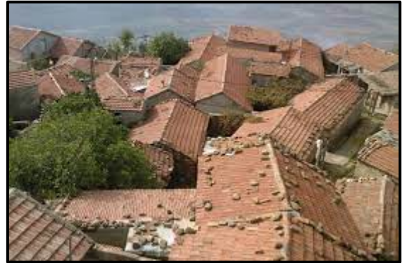
Figure85 : toitures des maisons d'un village kabyle. Source : Google image.
