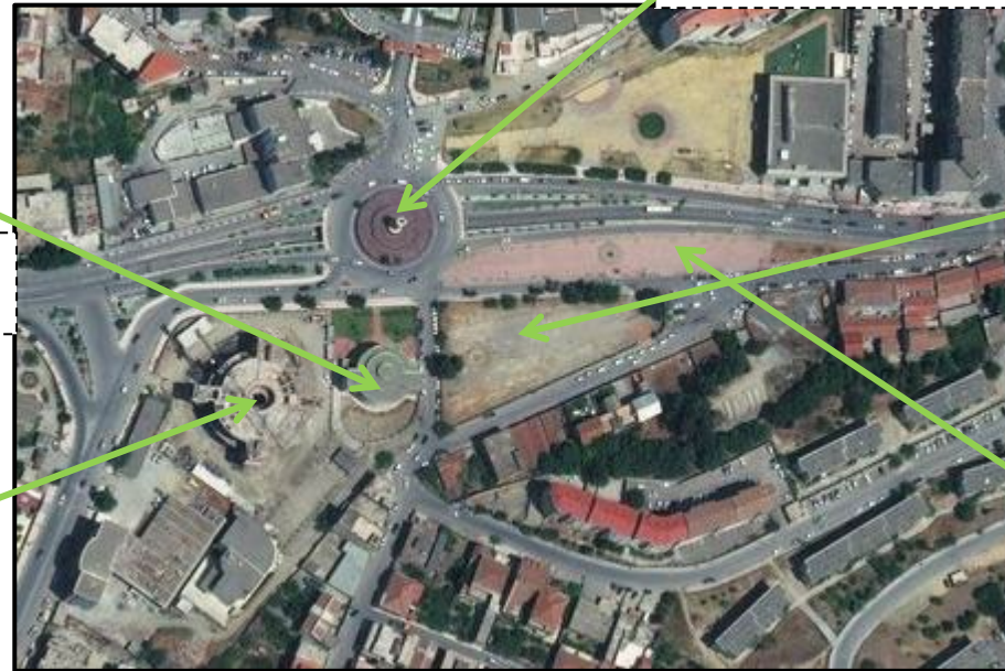
Figure158: Vue depuis et vers le site d'intervention
