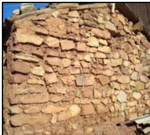
Figure83 : Utilisation du matériau terre comme mortier. Source : pierreseche.com
