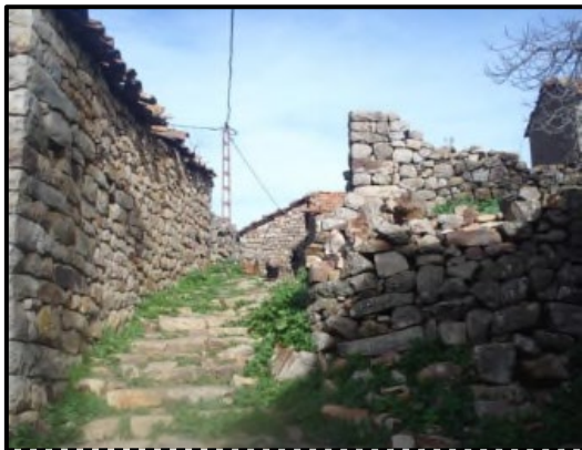
Figure54 : Ruelle dans le village de Bou-Mensour. Source : auteurs
