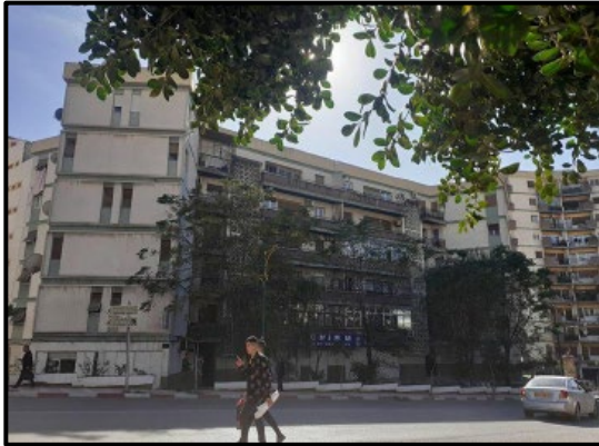
Figure137 : Bâtiments d'habitation de la cité 20 Août.
