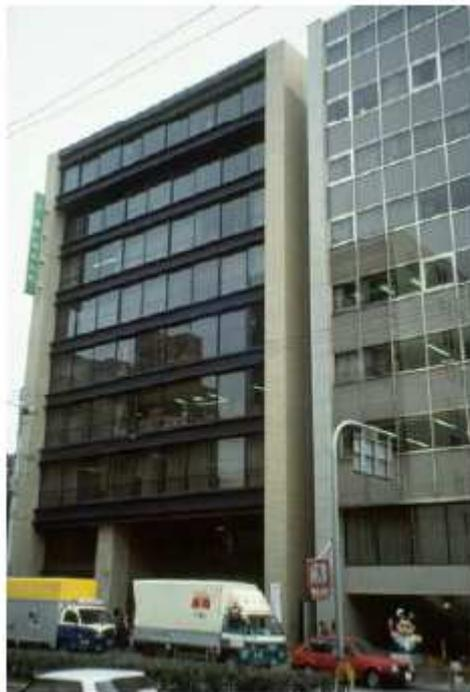
**Figure I.35: (Japon, Document X)** Joint parasismique vertical large entre deux constructions
