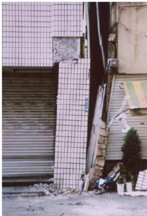
**Figure I.37 :** Entreoquement de bâtiments pour cause de joint trop étroit au regard des déplacements réels.
