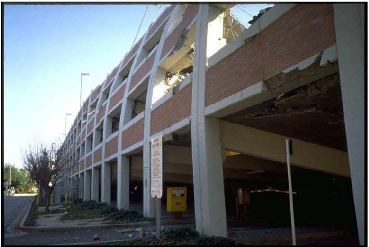
**Figure I.29 : dommages sismique à cause de l'irrégularité (Séisme de Northridge, 1994).**
