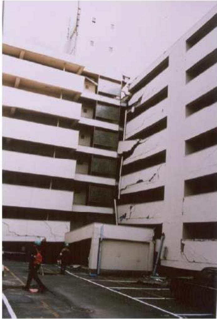
**Figure I.24 : dommages sismiques occasionnes aux bâtiments comportant des ailes.**
