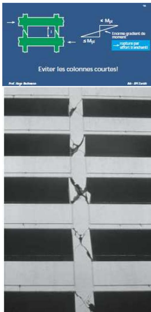
**Figure I.30 : Les fissures en croix et les ruptures par effort tranchant qui ont affecté les colonnes courtes de ce parking ont presque entraîné son effondrement (Northridge, Californie, 1994).**
