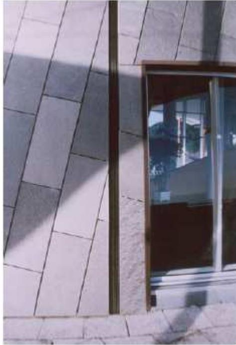
**Figure I.36 :** (Basse-Terre, Document P. Balandier) – Joint parasismique vertical étroit entre deux parties d’un même bâtiment. Le joint PS est couvert d’un couvre joint souple.
