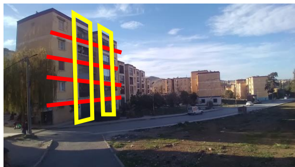
Figure 35: cité 200logements , source : auteurs
