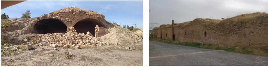
Figure72 : le bâtiment d'ancien prison, source : auteurs
