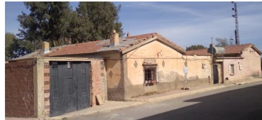
Figure58: habitations coloniales individuelles, source : auteurs
