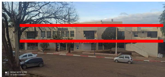
Figure 37 : façade du bâtiment de la maison des jeunes, source ; auteurs
