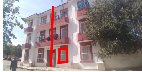
Figure 57 : logement de fonction des gendarmes, source : auteurs
