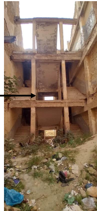
Figure69 : vue sur l'intérieur du bâtiment de caserne, source : auteurs
