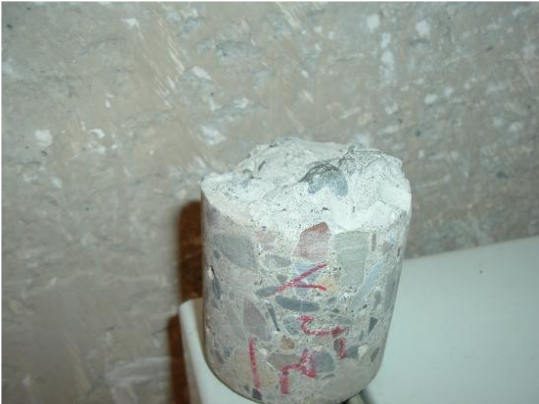
Figure II.1 : Carotte montrant la constitution d'un béton prélevé sur un voile
