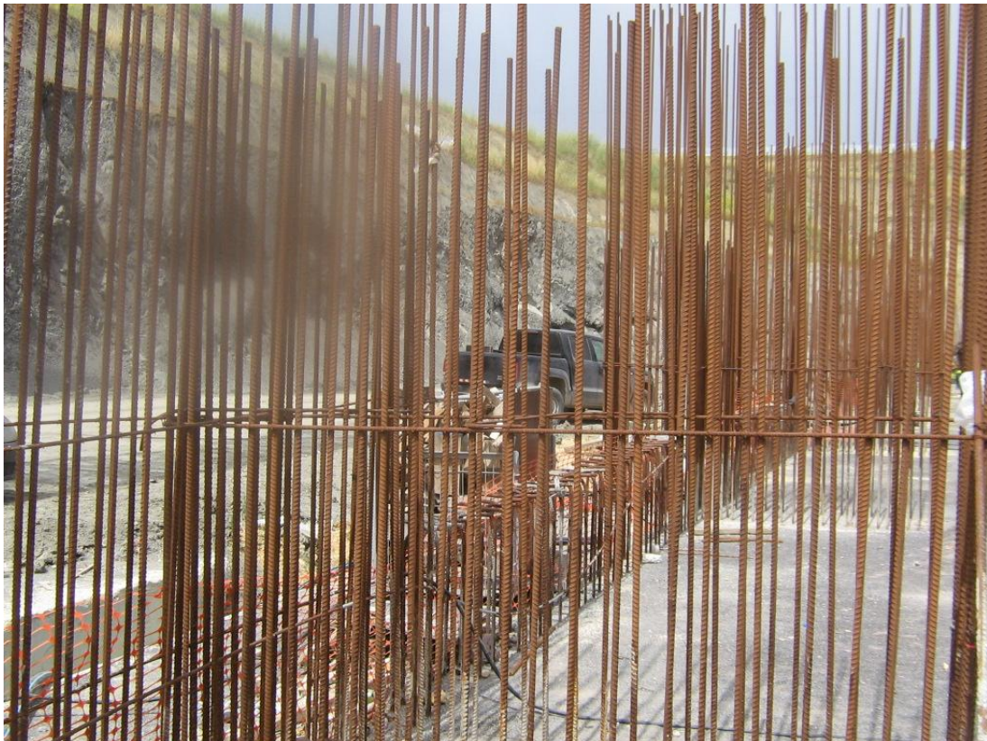
Figure II.9 : Ferrailage d'un voile (nouveau stade de la JSK. Boukhalfa, Tizi-Ouzou).
