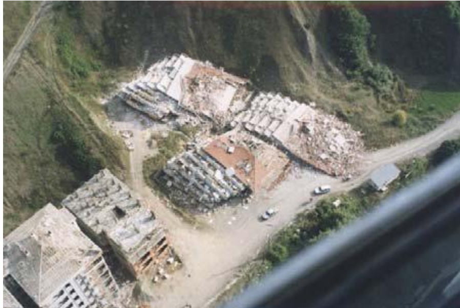
Figure I.18 : Séisme d'Izmit en Turquie [7]
