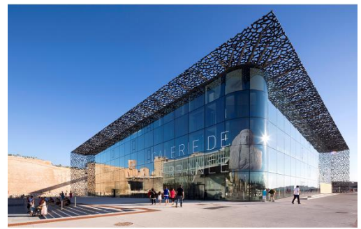
Fig.3.25. Façade principale du MuCEM Source. mucem.org
