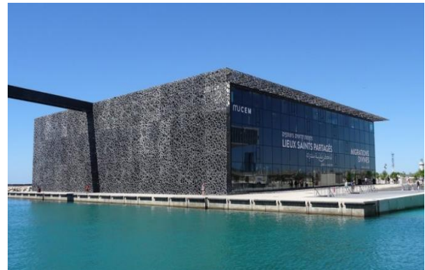
Fig.3.19. Vue sur le MuCEM Source. mucem.org
