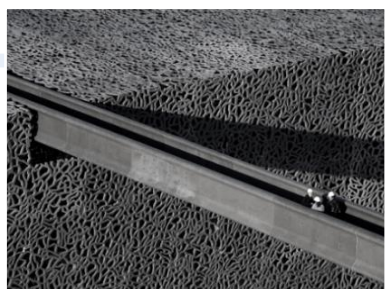
Fig.3.31. Vue sur la passerelle Source : mucem.org
