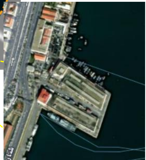
Fig.4.2. Vue aérienne sur l'assiette d'intervention Source. Satellitepro
