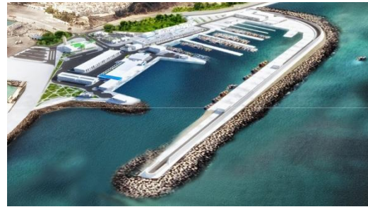
Fig1.27. Le port de pêche après intervention Source. portusonline.org
