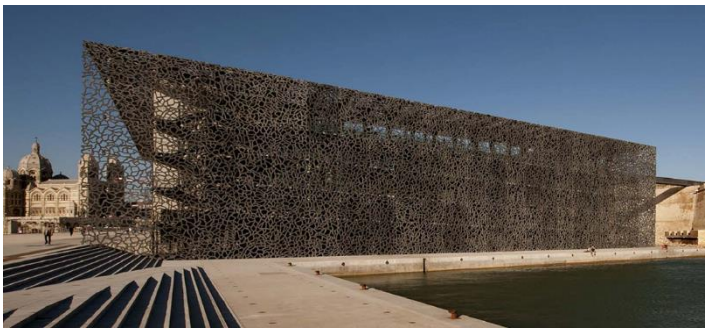
Fig.3.24. Façade sud du MuCEM Source. mucem.org
