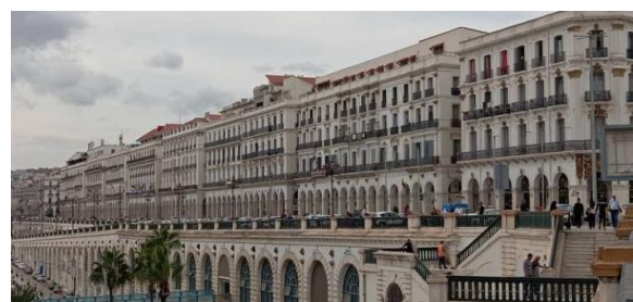
Fig.2.15. Façade Ouest de boulevard Che Guevara Source. Auteurs
