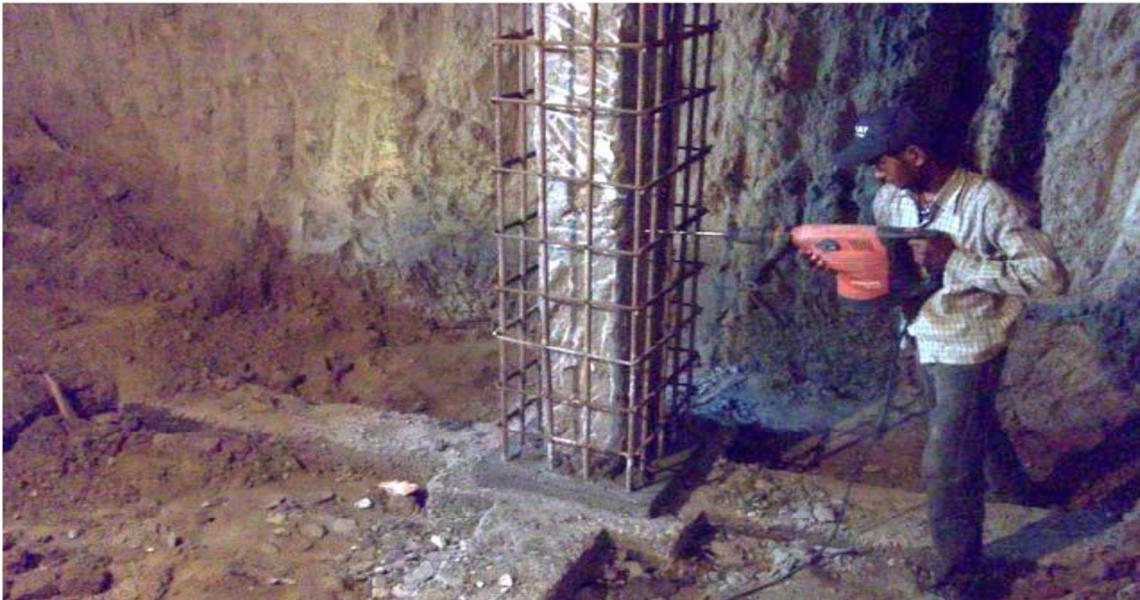
Figure.1.3 : Augmentation de la rugosité du poteau.
