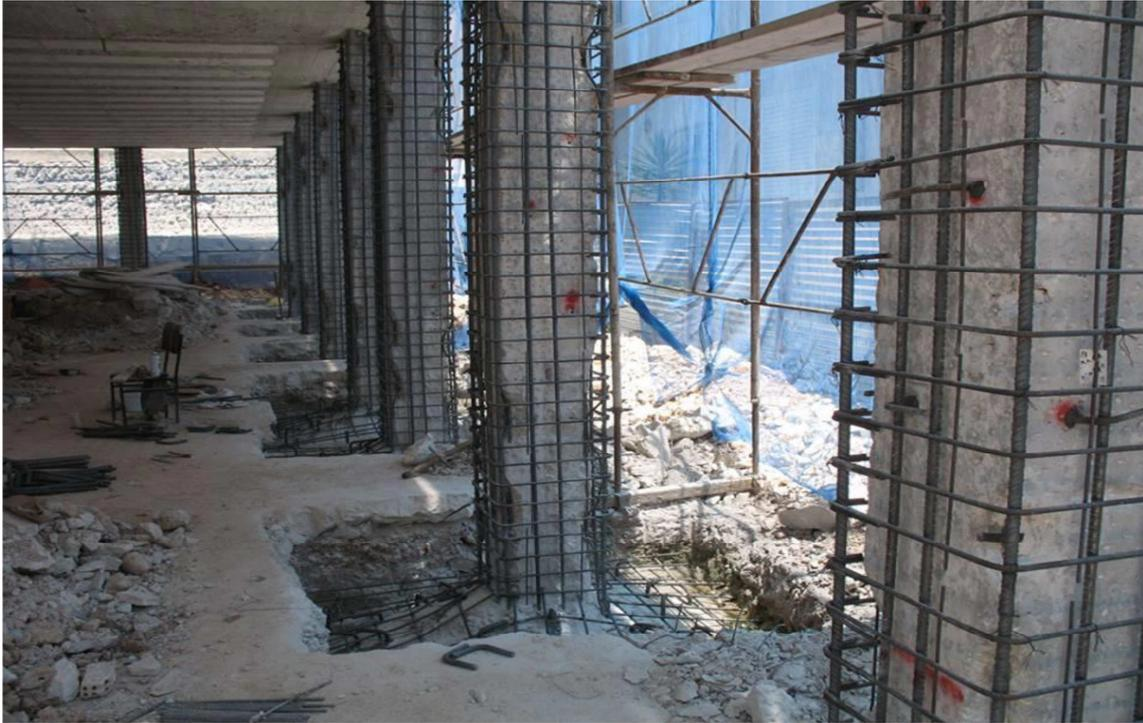
Figure1.4 : Mise en place des armatures de renforcement.
