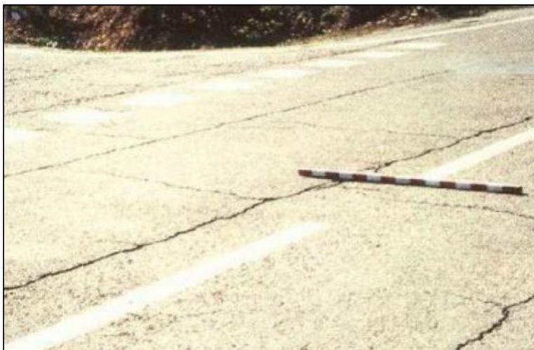
**Figure II.8. Fissure en dalle**
