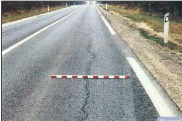
**Figure II.7. Fissuration longitudinale**
