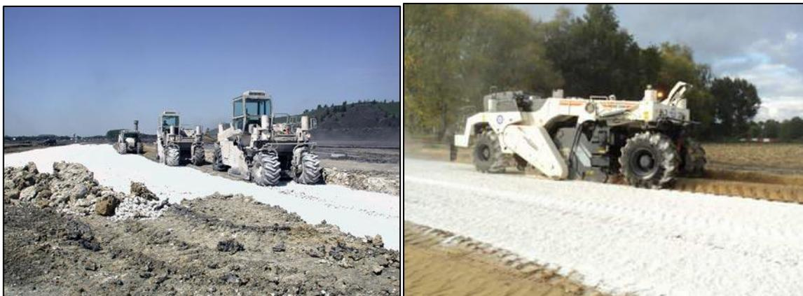
**Figure II.16. Traitement de sol par épandage de chaux**
