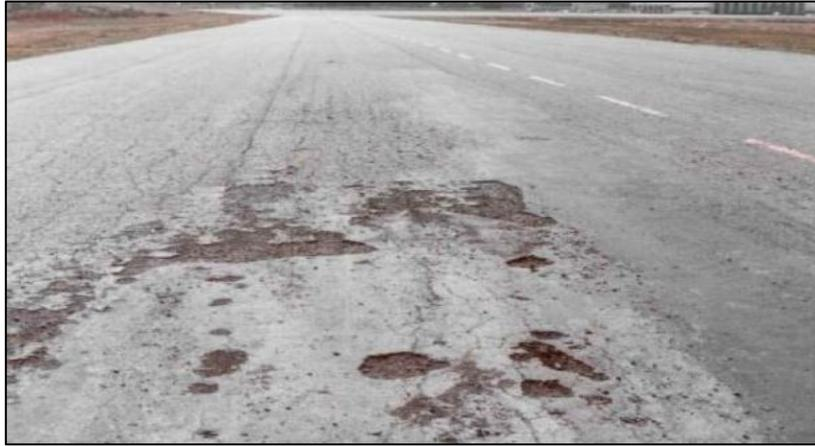
**Figure II.3. Dégradation d'arrachement**
