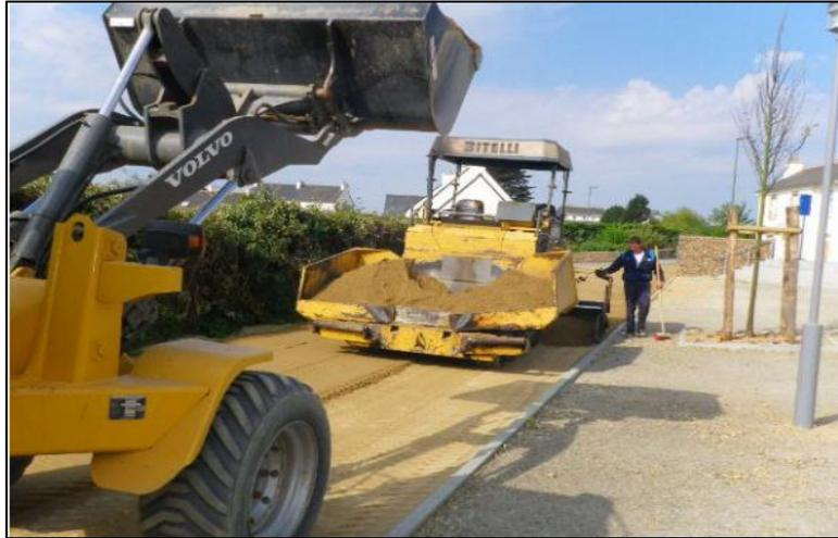
**Figure II.17. Traitement par ajout de tuf**
