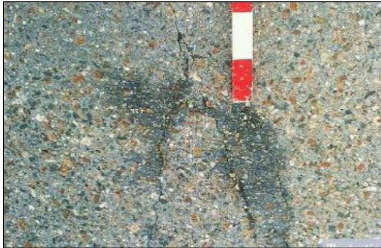
**Figure II.10. Fissures diverses en Y**
