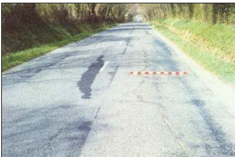
**Figure II.9. Fissure d'adaptation**
