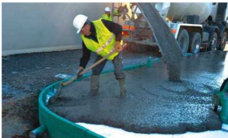
Figure I. 6 : Mise en œuvre d'un BAP [12]
