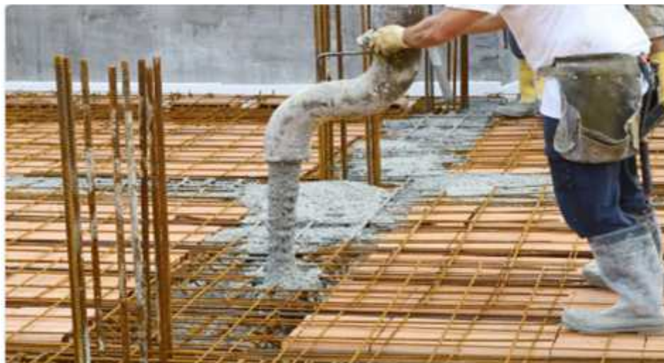
Figure I.7 : Application de béton autoplaçant sur des armatures [19]
