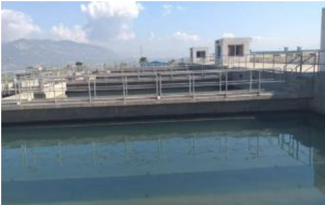
Figure. IV.10. : Les bassins de filtration
