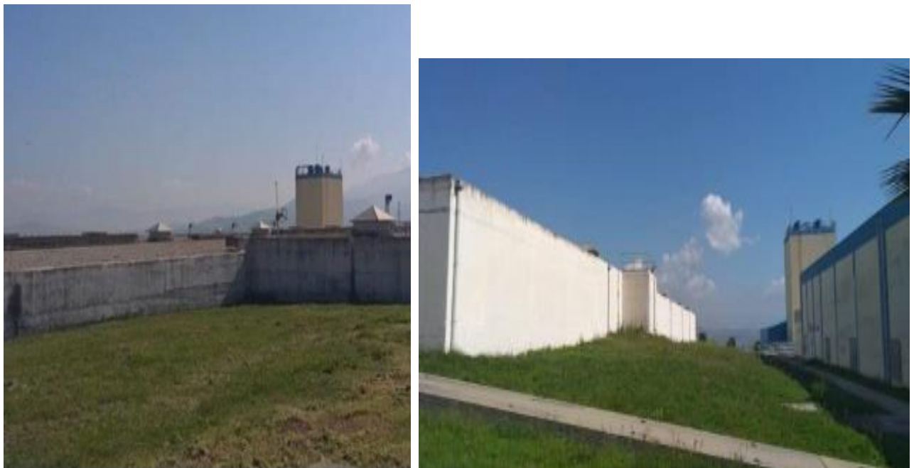
Figure. IV.12 : réservoir d'eau traité
