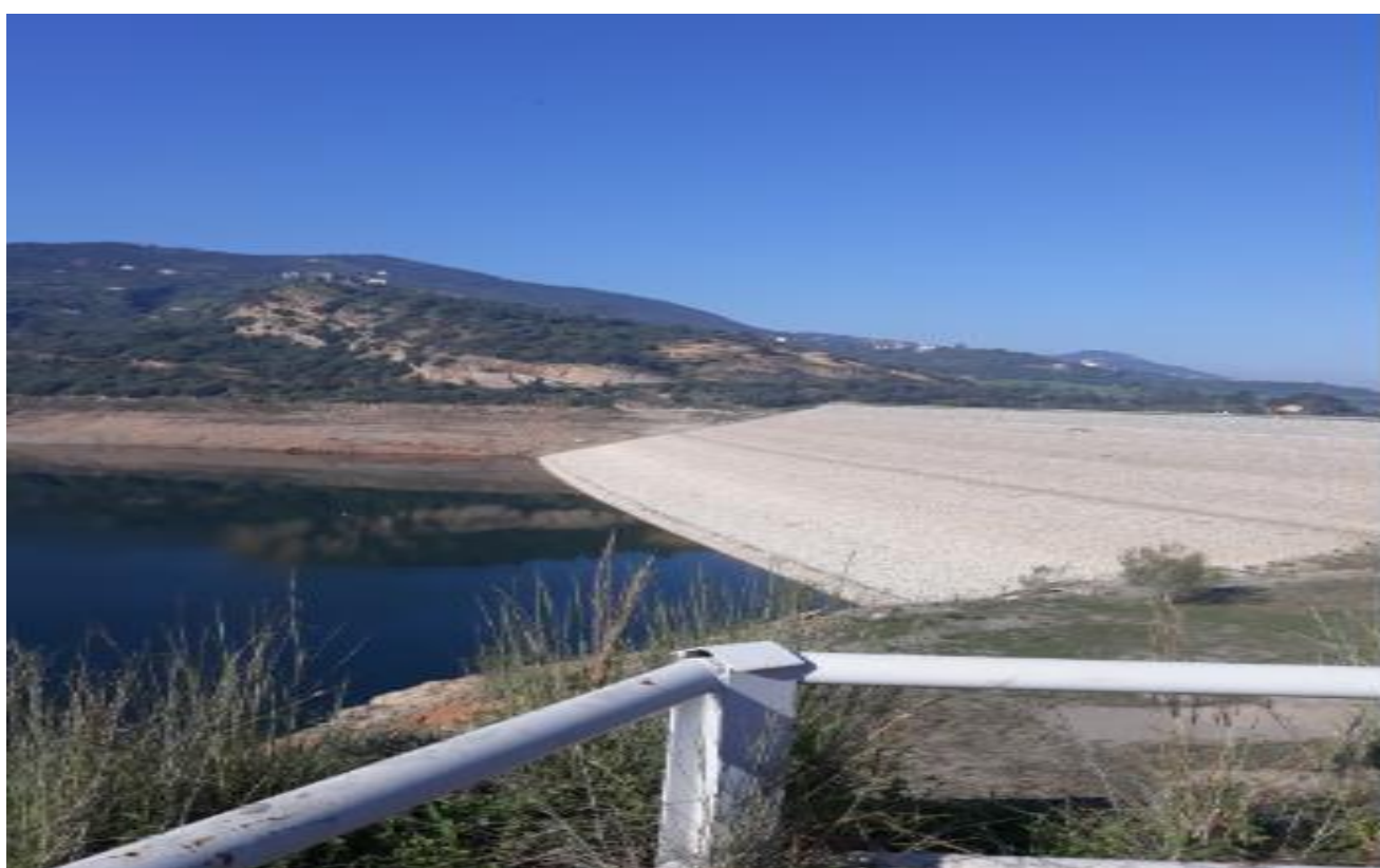
Figure VI.2 : La dige de barrage taksebt
