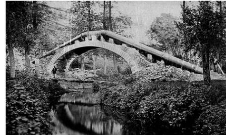
**Fig.2.24** : Typologie du pont-siphon
