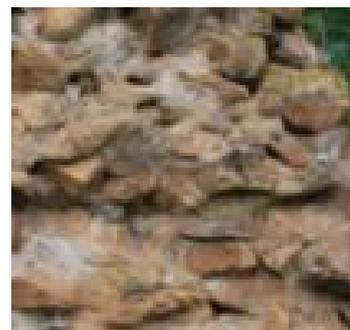
**Fig. 4.2** : Surface du blocage altéré par érosion pluviale
