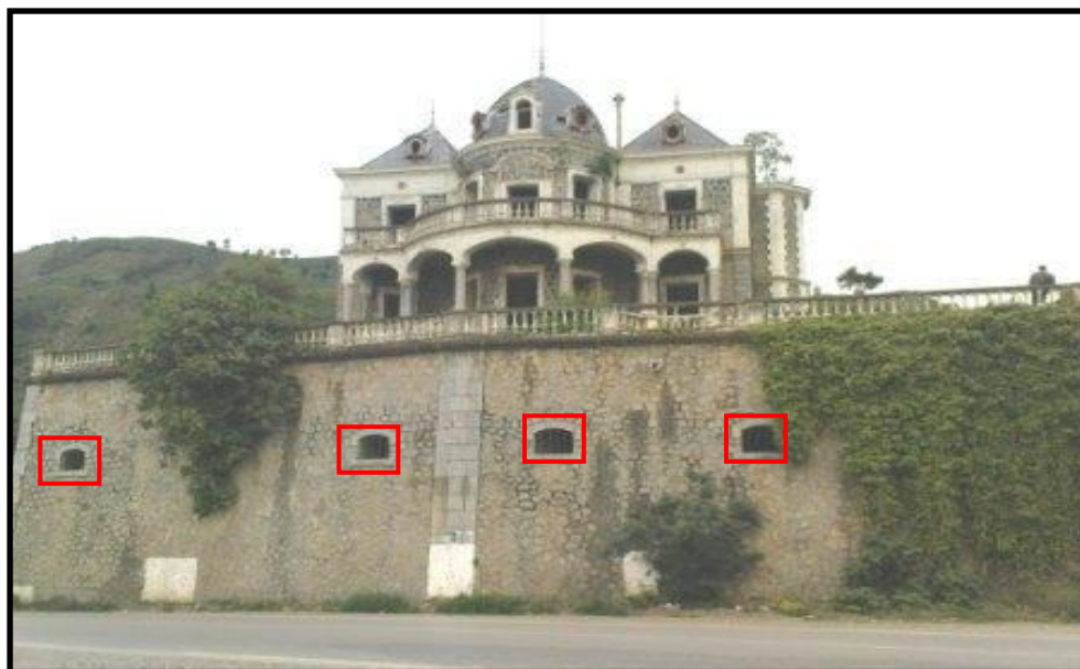
Figure 4. 19: Les ouvertures de la cave orientées au nord. Source : auteur (prise en 2008).
