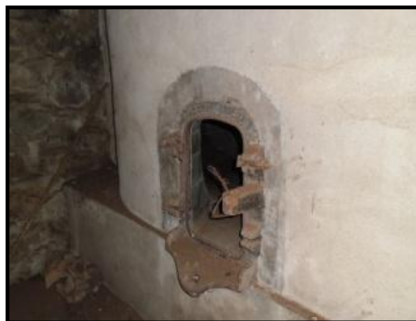
Figure 4. 24: Vue sur l'ouverture des cuves. Source : Auteur (prise en 2013).
