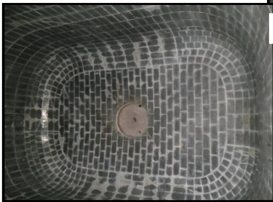
Figure 4. 23: Vue sur le revêtement intérieur des cuves.
