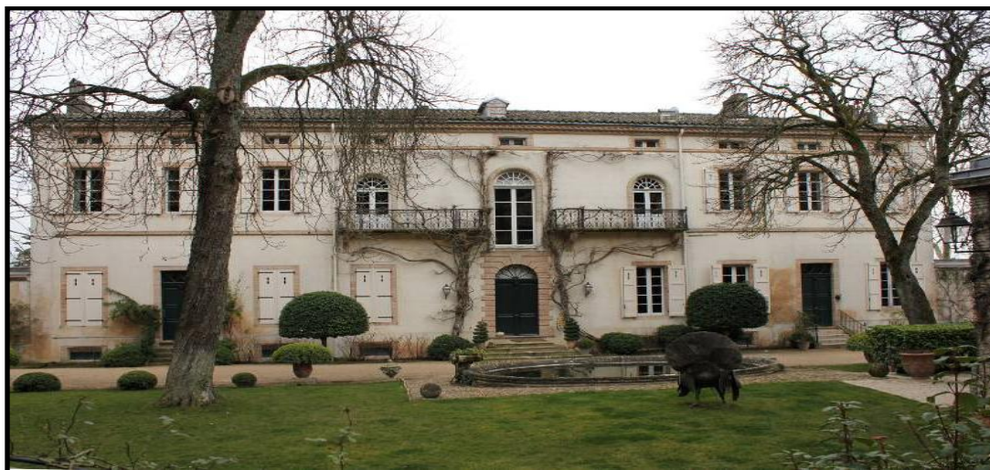
Figure 3. 24: Façade sud du château Gineste.
