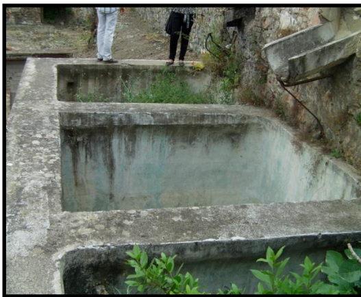
Figure 4. 51: Vue sur les bassins de foulage. Source : BET Feredj.T (prise en 2012).
