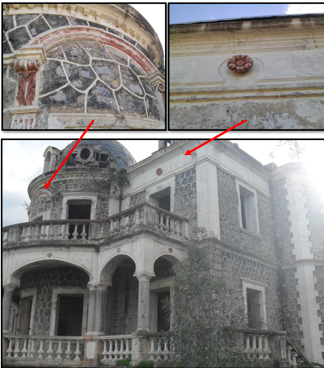
Figure 4. 64: Vue sur les détails de la façade principale du château (en cours de réhabilitation). Source : auteur (prise en 2012).
