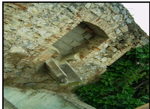
Figure 4. 52: Vue sur le glissoir. Source : BET Feredj.T (prise en 2012).
