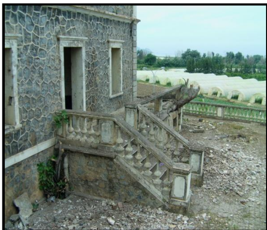
Figure 4. 26: Vue sur l'entrée EST du RDC. Source : auteur (prise en 2013).
