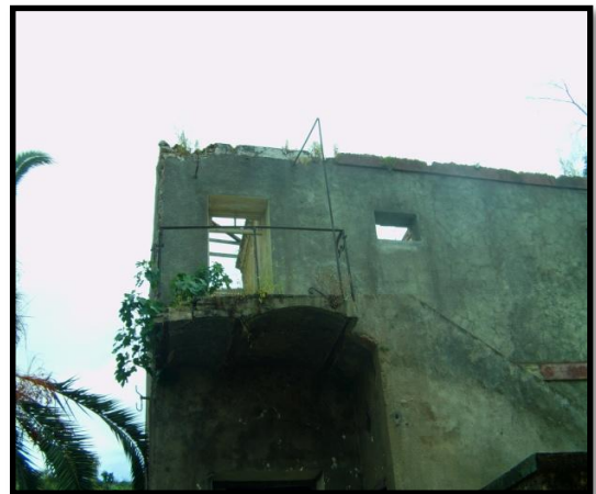
Figure 4. 44: Vue sur l'entrée du logement du régisseur. Source : auteur (prise en 2012).
