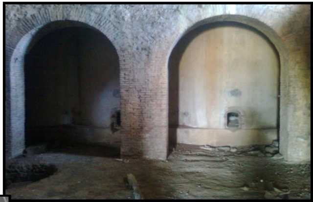
Figure 4. 22: Les cuves à l'intérieur de la cave.
