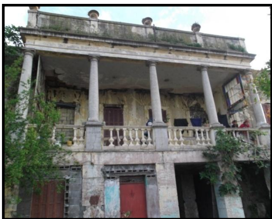
Figure 4. 6 : Le château d'El maghra. Source : auteur (prise le 26/04/2015).
