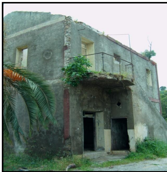
Figure 4. 12 : Le logement des domestiques. Source : auteur (prise en 2012).
