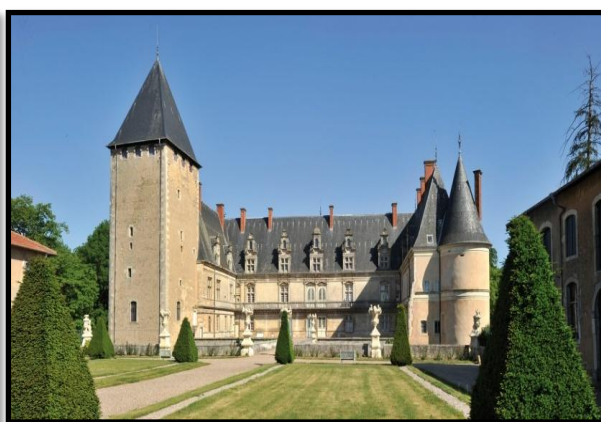
Figure 3.12: Façade principale du château de Fleville.
