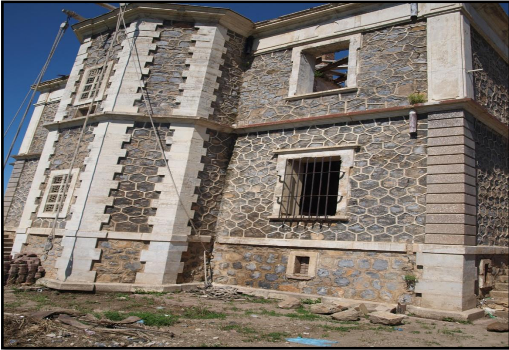
Figure 4. 68: Vue sur la façade Ouest du château. Source : Auteur (prise en 2013).
