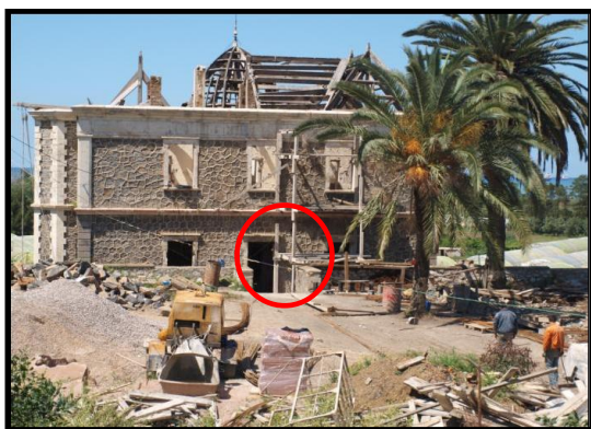
Figure 4. 28: Vue sur l'entrée de service du RDC. Source : auteur (prise en 2013).
