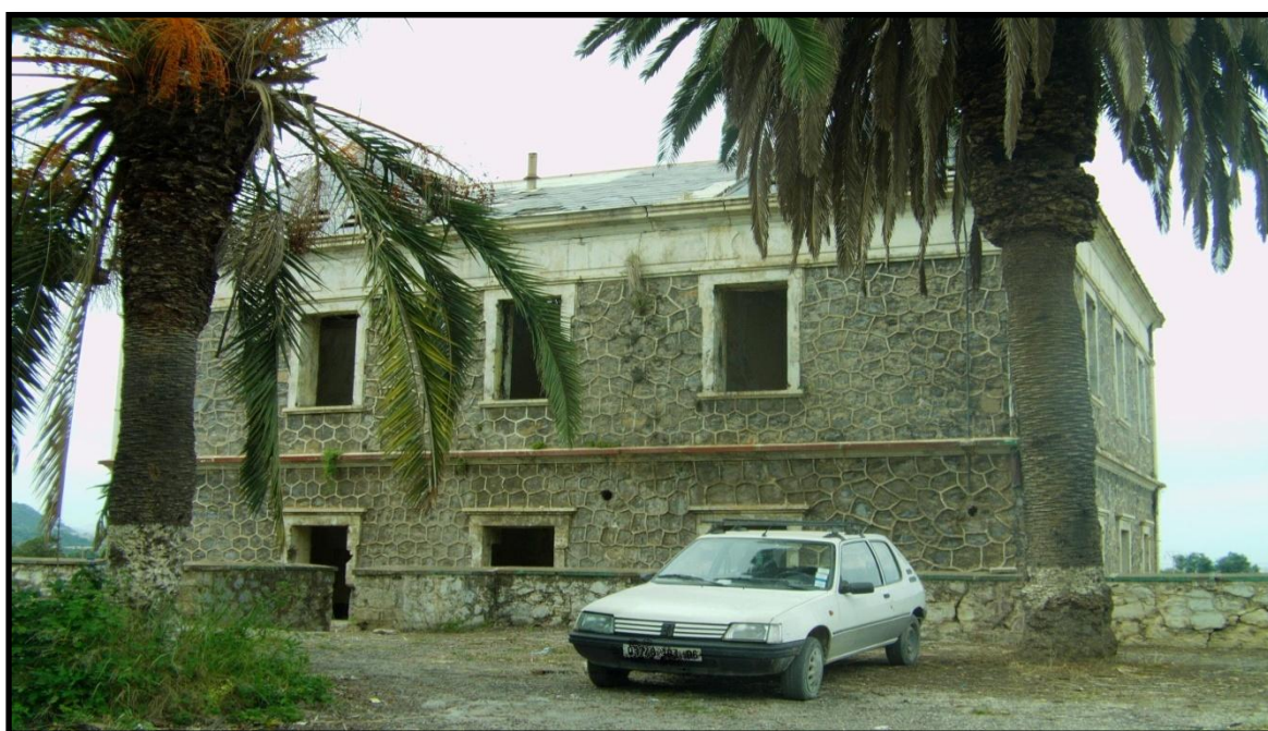
Figure 4. 67: Vue sur la façade sud du château (avant la réhabilitation). Source : BET Feredj.T. (2012).
