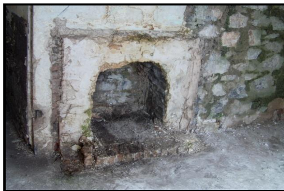
Figure 4. 29: Vue sur la cheminée de la chambre 1. Source : auteur (prise en 2012).
