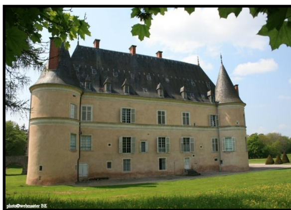
Figure 3.13: Façade secondaire du château de Fleville.
