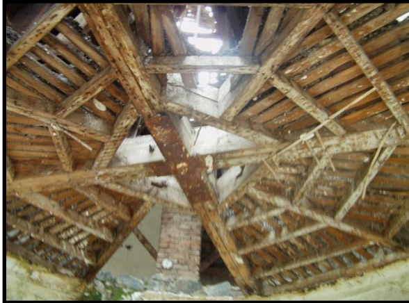
Figure 4.38: Vue sur le détail du plancher de la coupole. Source : auteur (prise en 2013).
