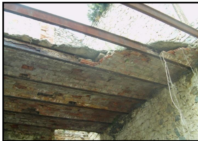
Figure 4. 57: Vue sur le plancher des cuiviers. Source : auteur (pris en 2013).
