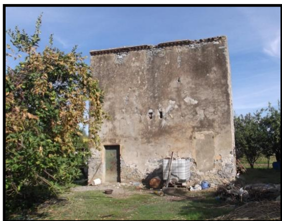
Figure 4. 60: Entrée sud de la remise agricole. Source : auteur (prise en 2015).
