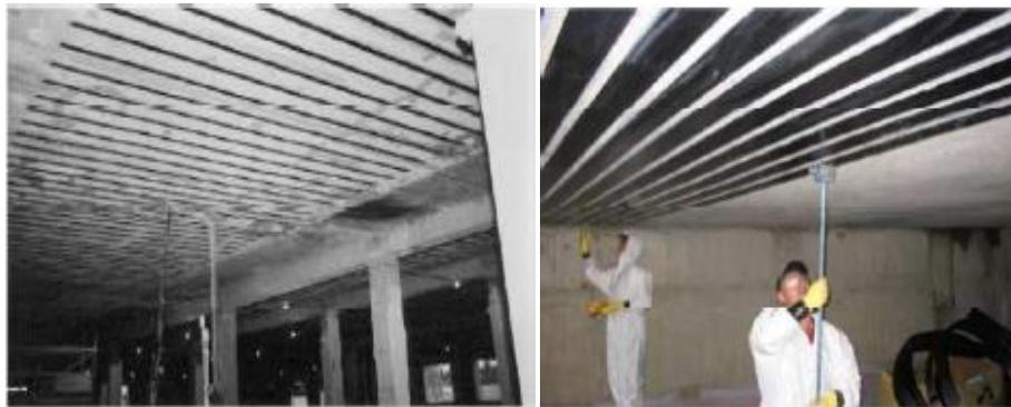
Figure III.17: Renforcement d'une dalle travaillant dans les deux sens par des lamelles en «PRF» [30].
