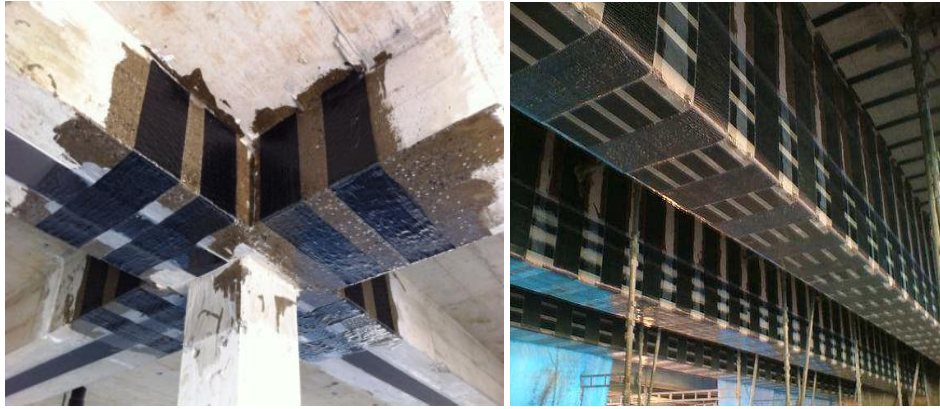
Figure III.16: poutres en BA renforcées par matériaux composites. [31]
