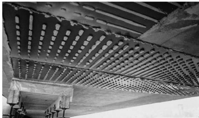
Figure III.4: Renforcement d'un viaduc par tôles collées. [47]
