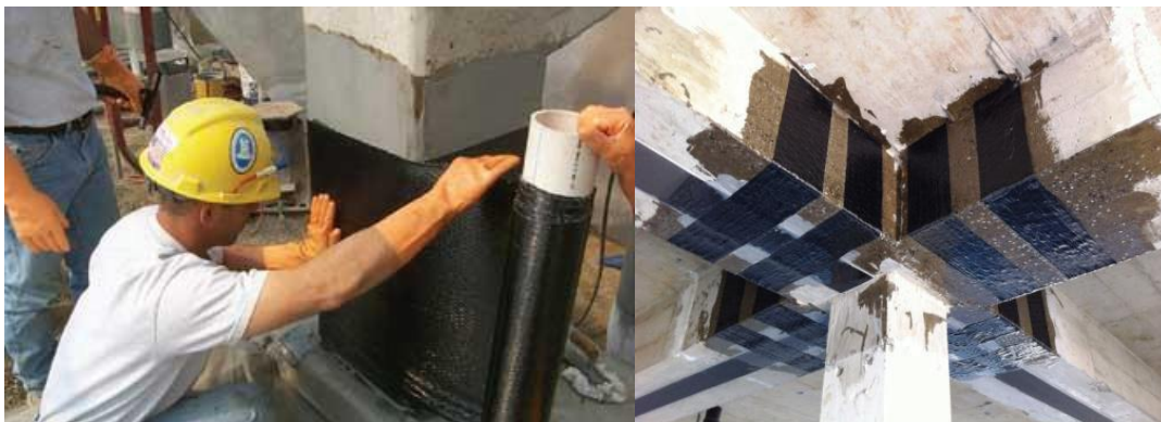
Figure III.12 : Illustration renforcement par stratification au contact avec FRP carbone [29]
