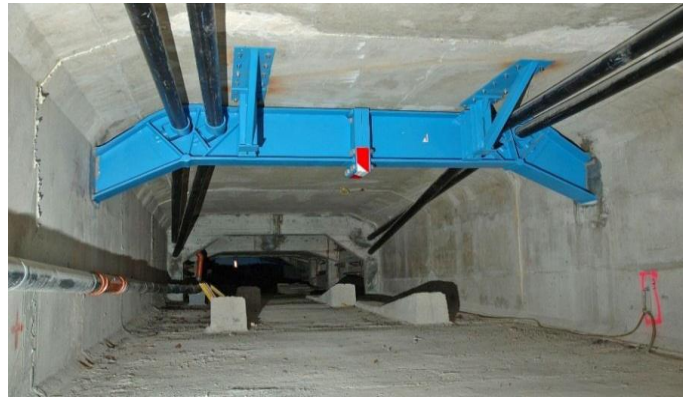
Figure III.5: précontrainte additionnelle. [25]
