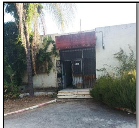
Figure 56: vue extérieure de l'administration. Source : Auteurs.
