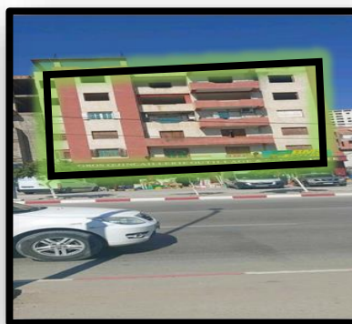
Figure 91 : vue sur l'immeuble mixte. Source : Auteurs.
