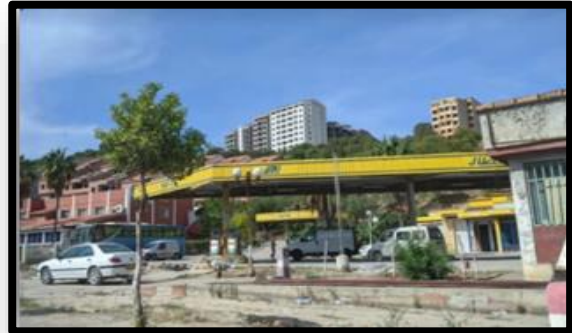
Figure 114 : Vue sur la station de services. Source : Auteurs.
