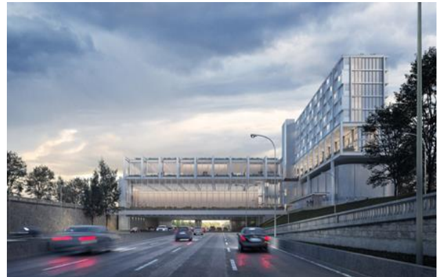
Figure 179 : vue du projet.
