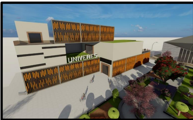
Figure 115 : Le centre commercial après l'intervention. Source : Auteurs.
