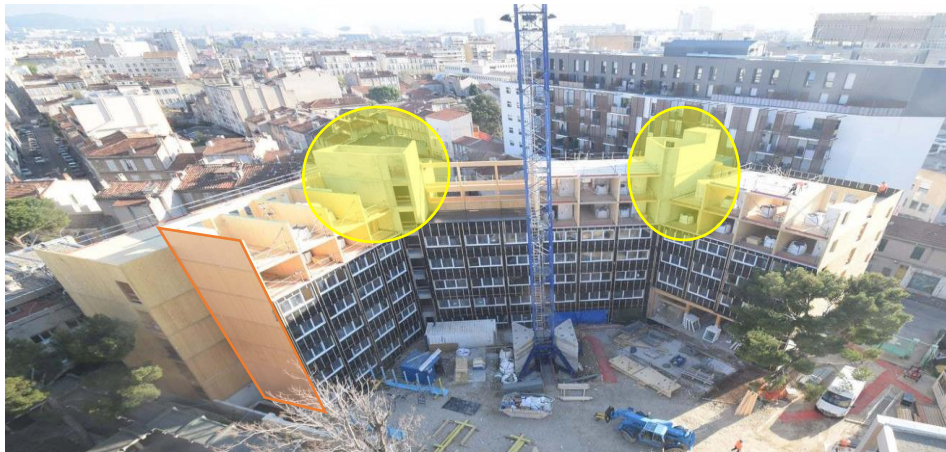
Figure 175 : structure en béton armé pour les escaliers et l'ascenseur. Source : Pinterest.
