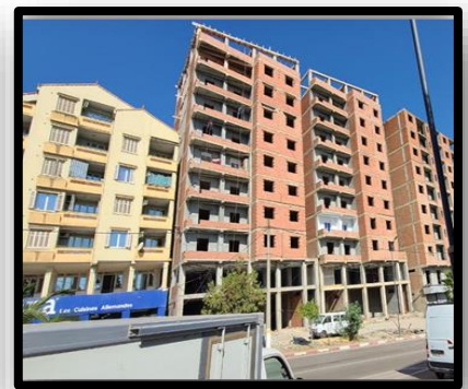
Figure 89 : vue sur l'habitat collectif. Source : Auteurs.
