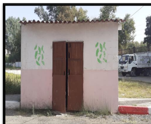
Figure 133 : Vue sur les locaux techniques. Source : auteurs.
