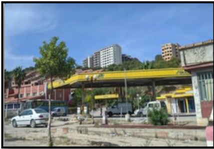
Figure 43: Station de service. Source : Auteurs.
