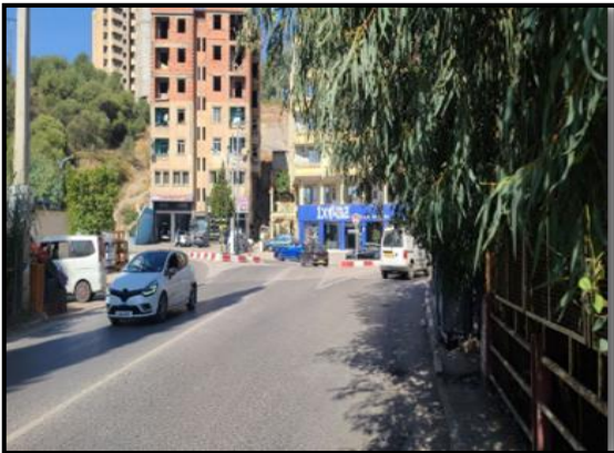
Figure 37: Vue sur l'intersection entre CW100 et Boulevard Krim Belkacem. Source : Auteurs.
