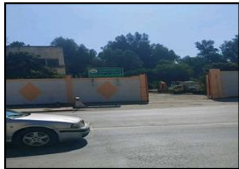
Figure 47: unité des travaux publics. Source : Auteurs.
