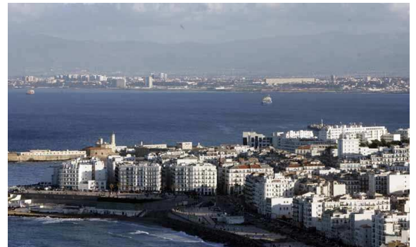
Photo 40 : vue sur le complexe ELKITTANI Source : WWW.google.com
