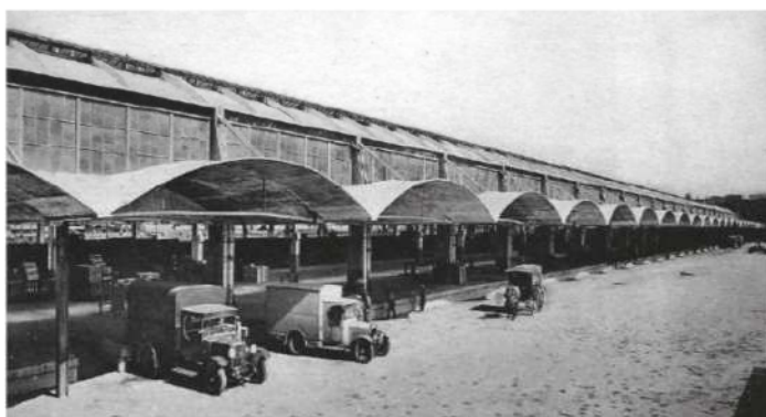
Photo 74 : le hall Freyssinet: avant rénovation
