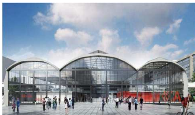
Photo 75 : le hall Freyssinet en 2016
