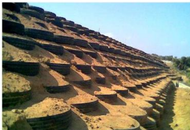
Figure I.11. Chantier expérimental PneuSol à Bou-Smail
