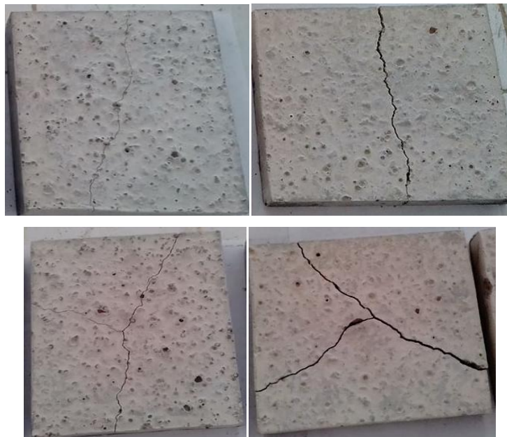
Figures III.13. Mode de rupture des dallâtes (une fissure et deux fissures).
