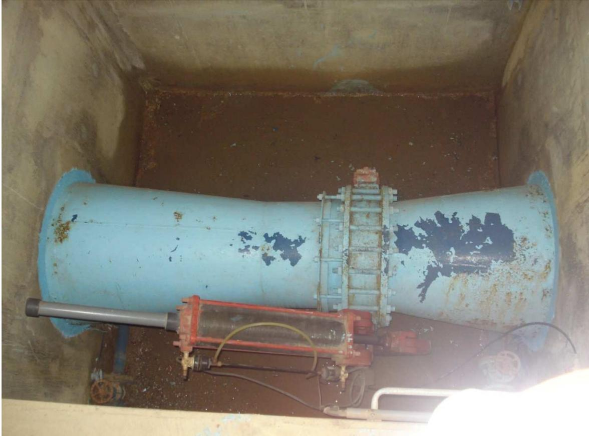
**Figure 2.1 : Image de la conduite reliant le filtre au déversoir.**
