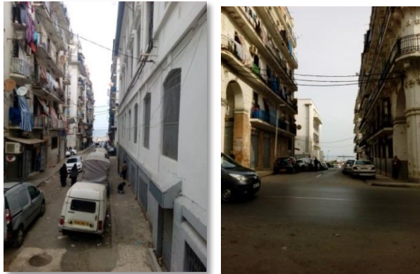
Figure 65 : vue sur quelques voies tertiaires Source : auteurs
