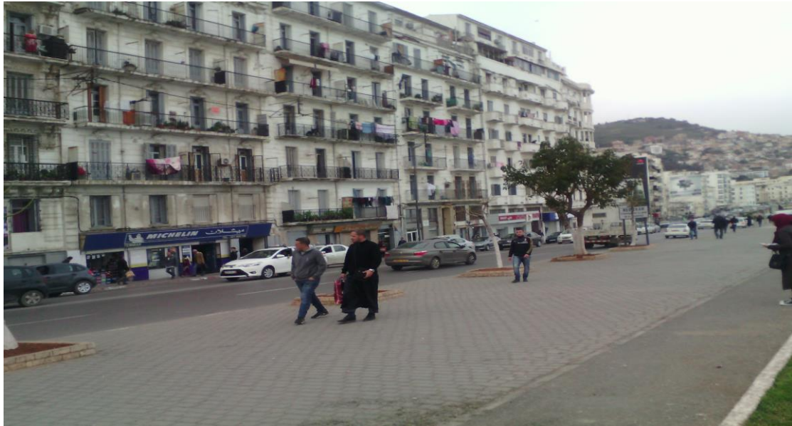
Figure95 : état actuel de la façade maritime Source : auteurs
