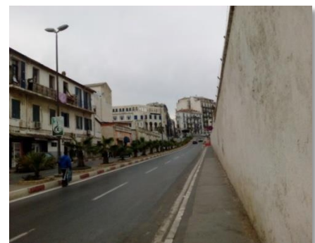
Figure56 : vue sur boulevard Saïd Touati Source : auteurs
