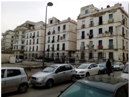
Figure 35 : bâtiments des HBM
