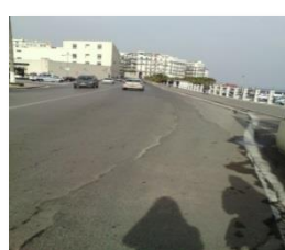
Figure 28 : Accès de coté DGSN Source :auteurs
