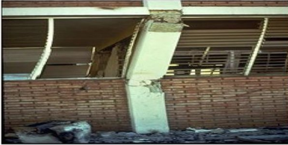
Fig. 2.14 : cisaillement du poteau du au remplissage [19].
