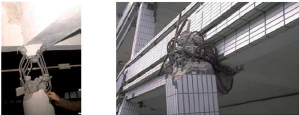
Fig. 2.1 : Eclatement de zones critiques, extrémités des poteaux et poutres.
