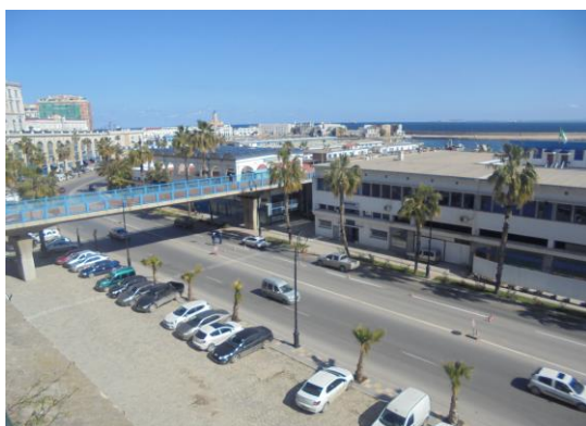
Fig. 103: Passerelle du front de mer Source : Auteurs
