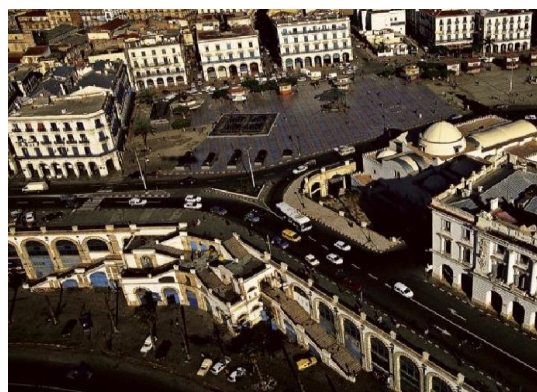
Fig.102: Les escaliers de la pêcherie Source : Auteurs
