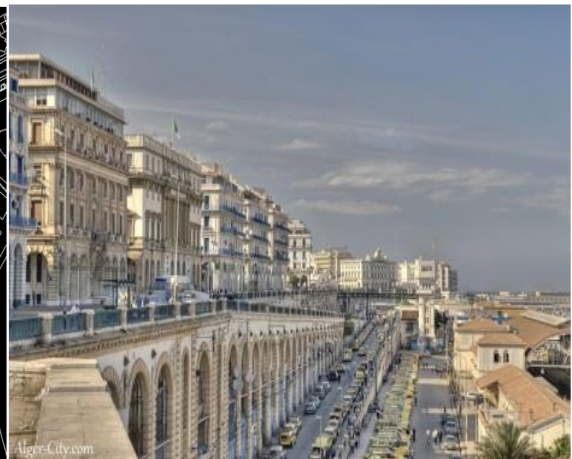
Fig.85: Boulevard Che Guevara Source : Auteurs
