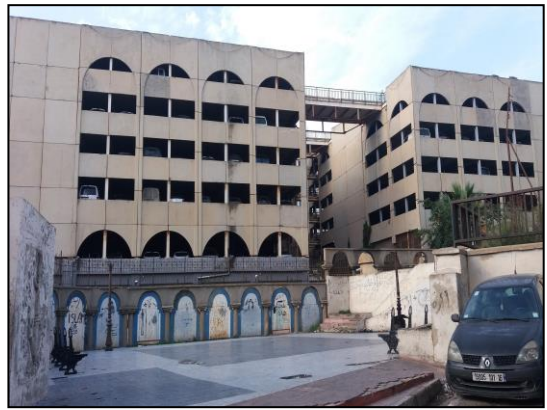
Fig.79 : Parking à étage Source : Auteurs
