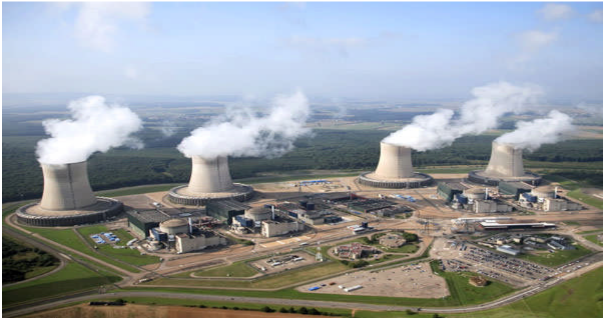
Figure I.3.a : Centrale nucléaire de Cattenom (France) [4].
