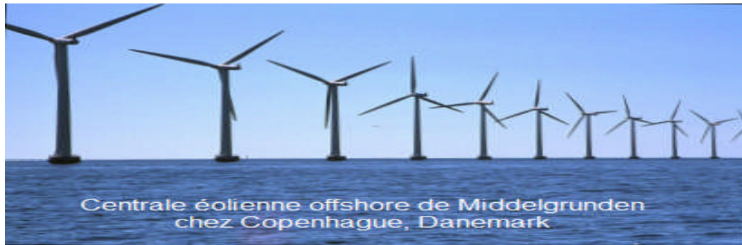
Figure I.8 : Centrale éolienne offshore de Middelgrunden chez Copenhague ,Danemark[6]
