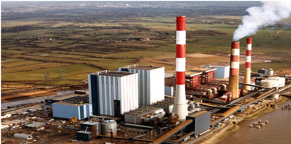
Figure I.1.a Centrale thermique de Cordemais, la plus importante centrale thermique Française[1]
