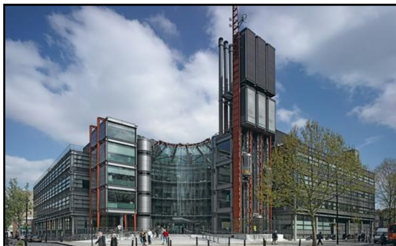
Fig. 67: Siège Channel 4 Angleterre Source: http://www.kescleaning.com/Past%20Projects.htm
