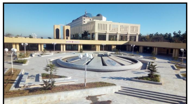
Fig. 41 : Place Carrée / Source : Prise par Auteurs
