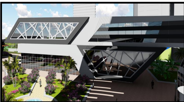
Fig.137 : Traitement de la peau extérieure de l'entité de la presse Source : Auteurs
