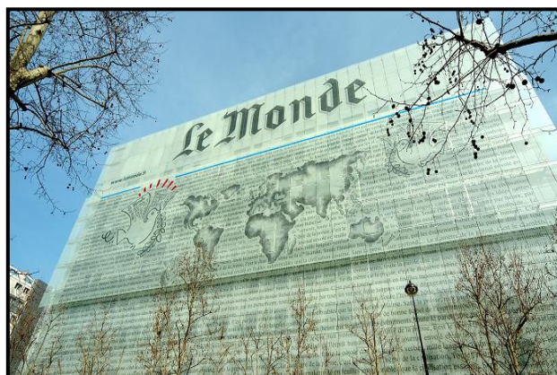
Fig.96 : Vue de la façade sud du siège du journal le monde Source: www. siège le monde/ bouygues immobilier.com
