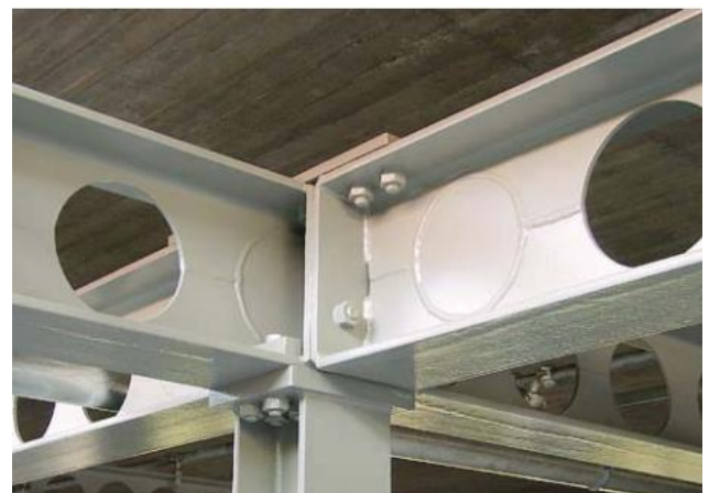
Fig.145 : Poutre alvéolaire Source : http://www.esse.fr/POUTRELLE-ACIER-IPE
