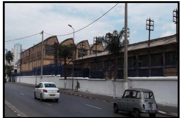
Fig. 5 : Hangars Industriels / Source : prise par Auteurs
