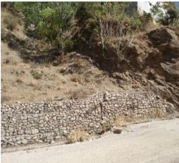
**Figure (25) : fissure dans le gabionnage [29].**
