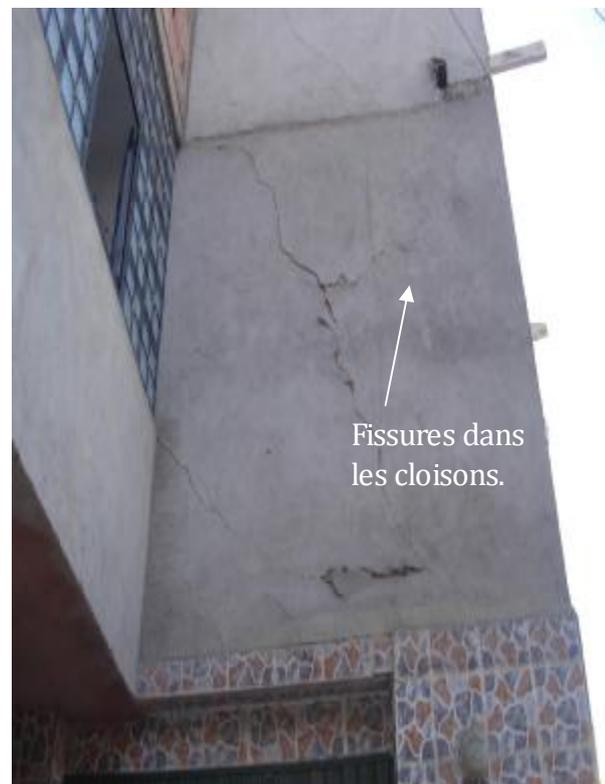
**Figure (29)** : Dégradation et affaissement du dallage du trottoir et fissures dans les cloisons de l'immeuble n° 19 [31].
