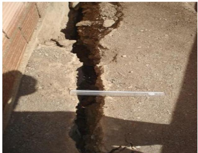
**Figure (27) :** la fissure apparue au sud de l'immeuble incluant une menuiserie [29].
