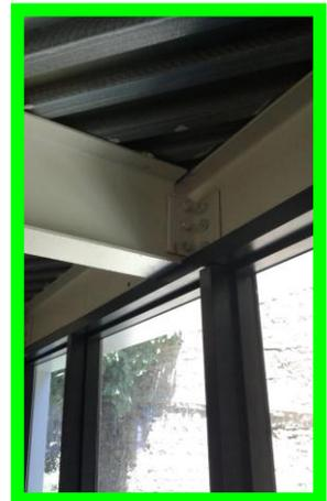
Figure 172 : Assemblage poteau poutre
