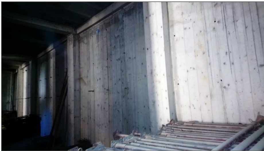
Figure(I.2) : photo prise à Krim Belkacem d'un mur de soutènement solidaire à la structure vue d'intérieur
