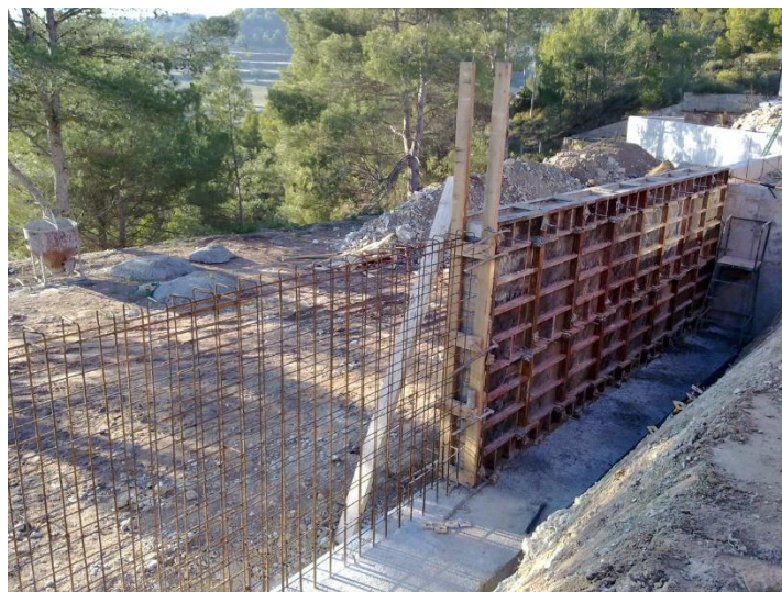
Figure II.4 : Mur en béton armé réalisé sur site.
