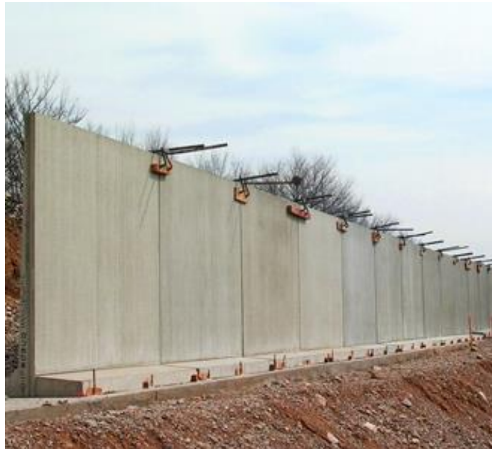
Figure II.3 : Mur en béton armé préfabriqué.
