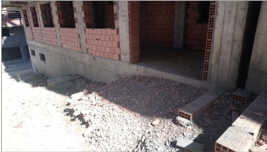
Figure(I.1) : photo prise à Krim Belkacem d'un mur de soutènement solidaire à la structure vue d'extérieur
