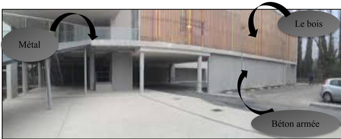
Figure 158 : Les matériaux de construction
