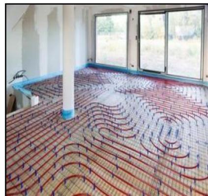
Figure 68 : Plancher chauffant rafraichissant
