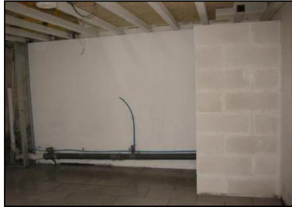
Figure 416 : Cloison en siporex
