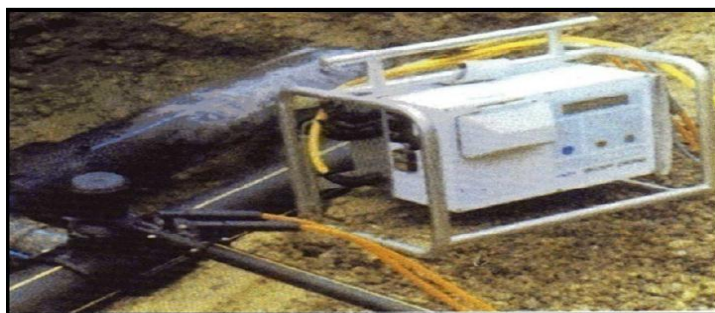
Figure IV.3 : Raccordement par accessoires électro-soudable
