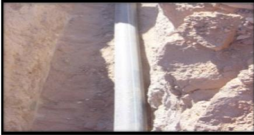
Figure VII.1 : pose des conduites en terre
