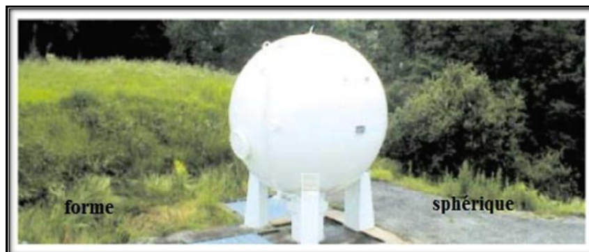
Figure VIII.7 : Les différentes formes de réservoirs anti-bélier
