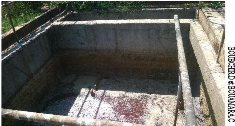
**Figure (22)** : Dégraissage au niveau de la STEP
