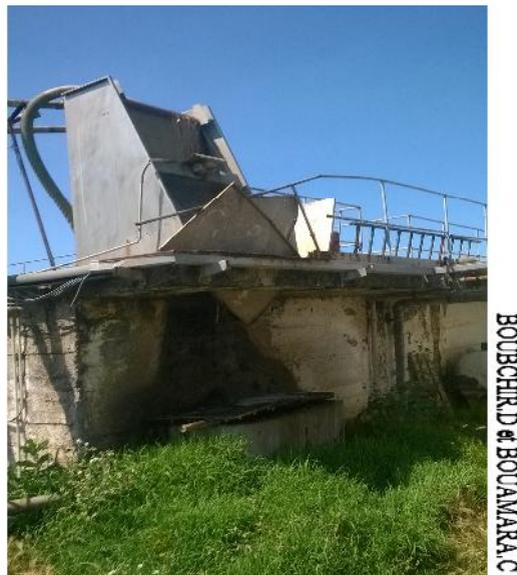
**Figure (23)** : Tamis vibrant de la STEP
