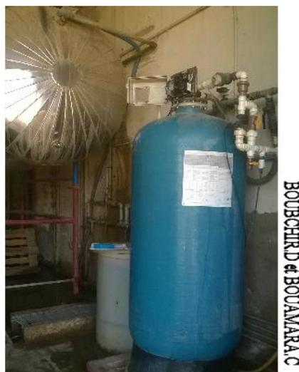
**Figure (16) :** Adoucisseur à résines échangeuses d'ions
