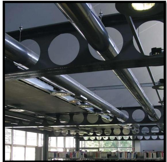
**Figure165** : poutres alvéolaires en acier
