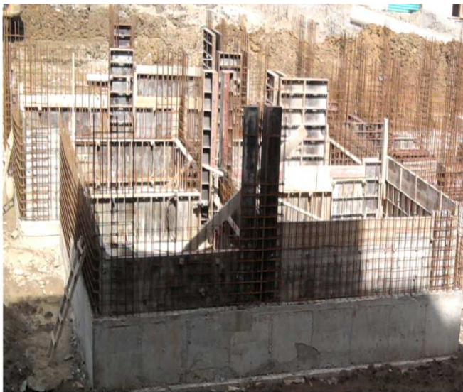
Fig.II.1 : coffrage tunnel.
