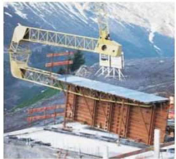
Coffrage tunnel demi-coquille.
