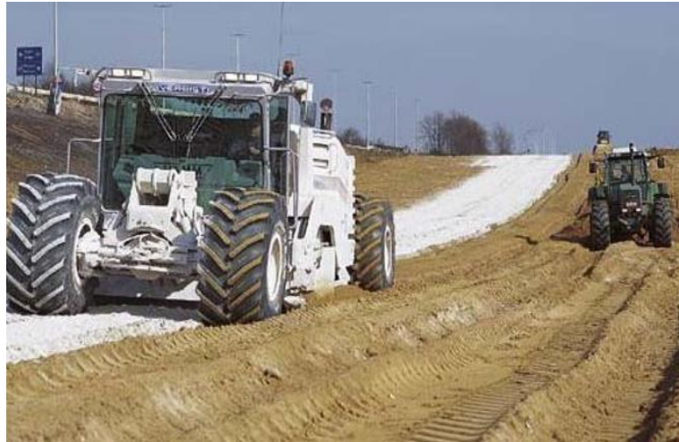
Figure II.5. Chantier de traitement d'un sol à la chaux.
