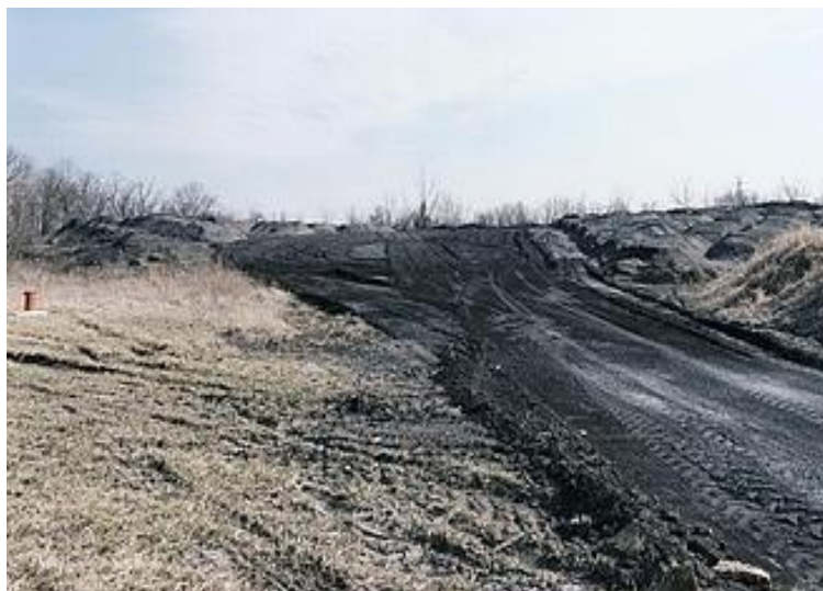
Figure II.10. Application des cendres volantes sur une route.
