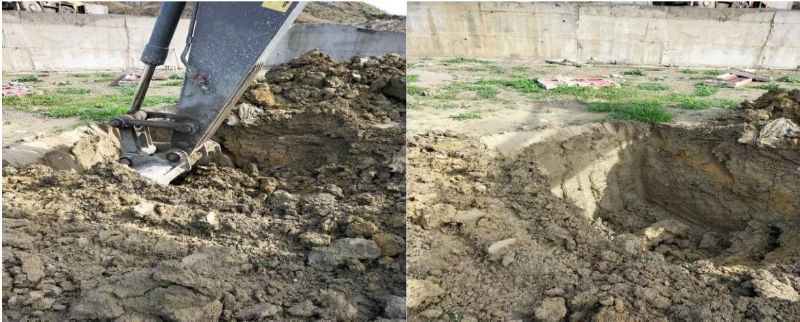
Figure III.2. Extraction du sol à l'aide d'une pelle mécanique.
