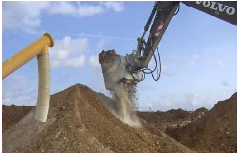
Figure II.6. Malaxage de sol avec le ciment.
