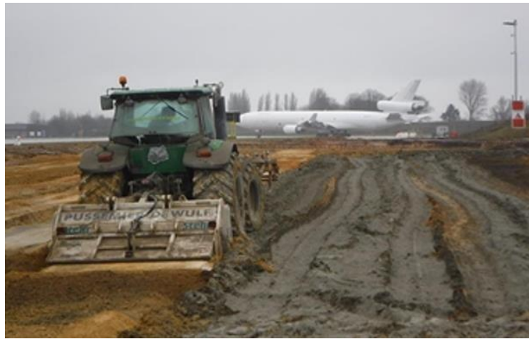
Figure II.7. Mise en œuvre de sol-ciment.
