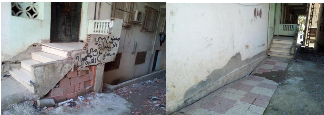
Figure I.14. Désordres dus au gonflement (Photo prise à Tizi-Ouzou).
