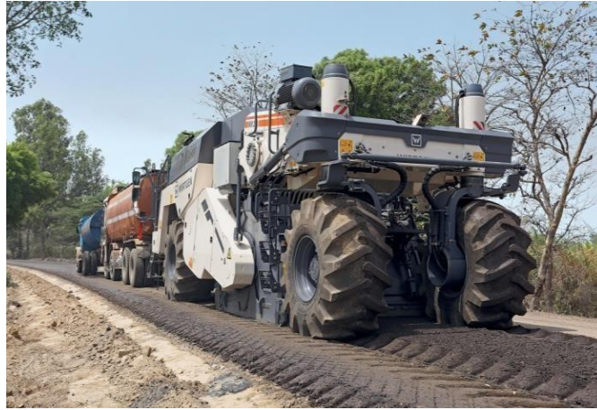
Figure II.12. Stabilisation d'un sol au bitume.
