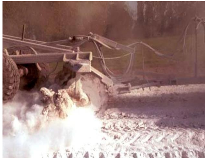
Figure II.19. Malaxage du liant avec le sol.
