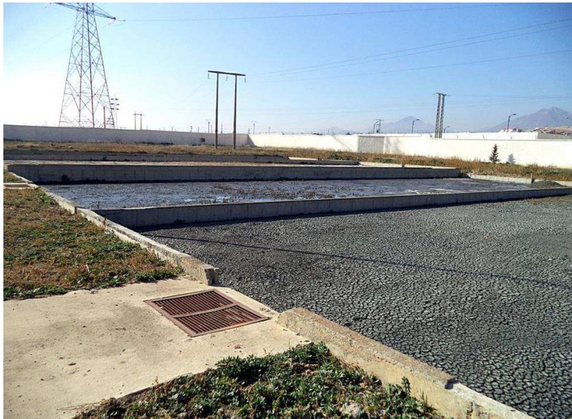
**Figure N°18 :** Photo des lits de séchage des boues. [41]
