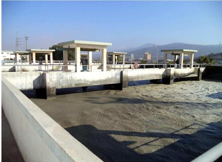
Figure N°14 : Photo du bassin d'aération. [41]
