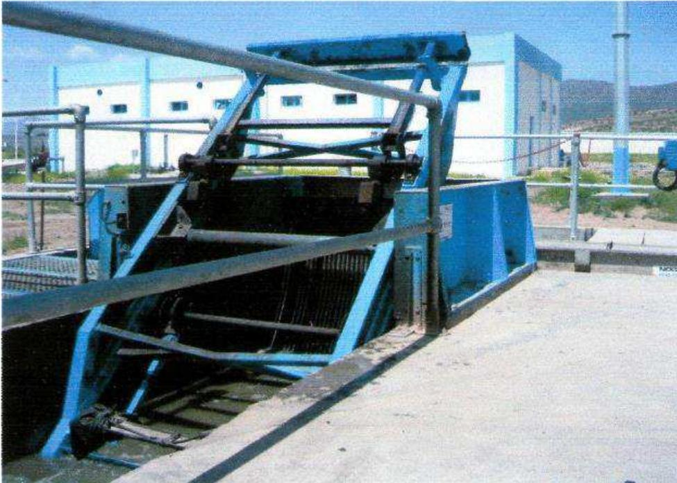
Figure N°12 : Photo du dégrilleur mécanique. [41]
