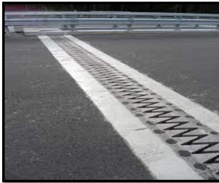
Figure IX.2. Joint du type Wd (souffle moyen)
