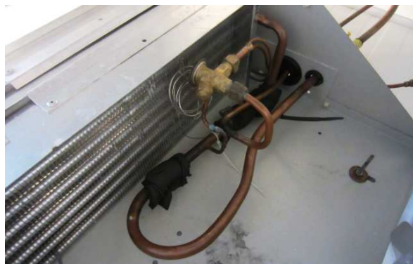
Figure II.1 Modèle d'un évaporateur à détente sèche
