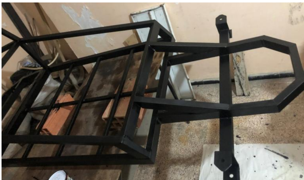
Figure IV.47 : application de l'antirouille sur le châssis.
