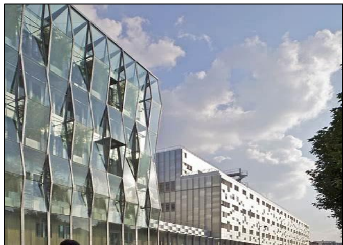
Figure 50 Façade en double peau vitrée – Hôpital Necker
