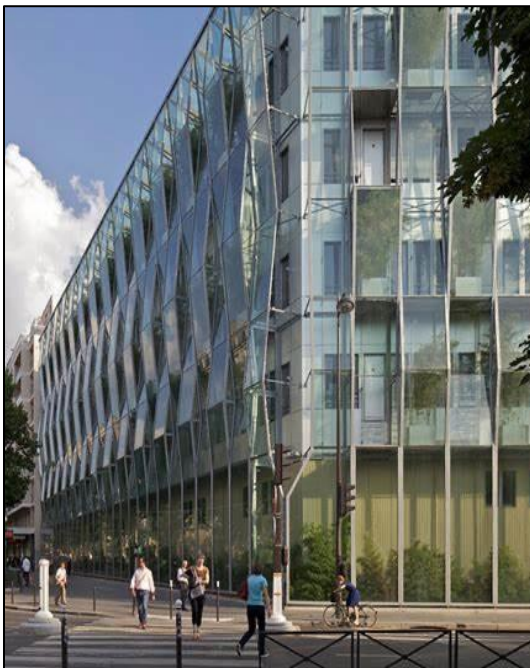
Figure 51 : Vue d'ensemble de la façade principale hospital Necker
