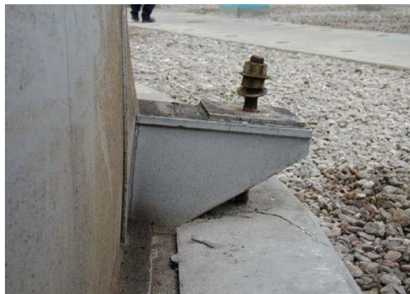
Figure 1-8 : Allongement d'une tige d'ancrage
