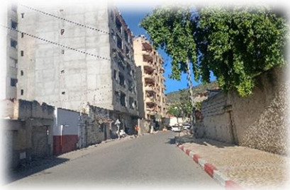
Figl. 59 : vue sur la voie Kesri amar Tronçon BC
