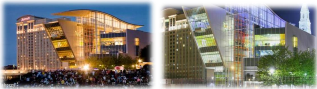
Fig.3. 21: photos des façades de projet
