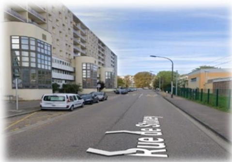
Fig2. 18 : aménagement d'un espace de stationnement
