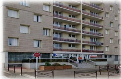
Fig2. 24 : requalification de rdc
