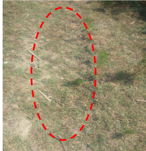
Figure 1.8 : Affaissement de la crête.
