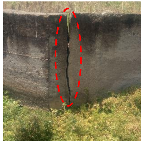
Figure 1.17: Ouverture du joint de rupture des bajoyers
