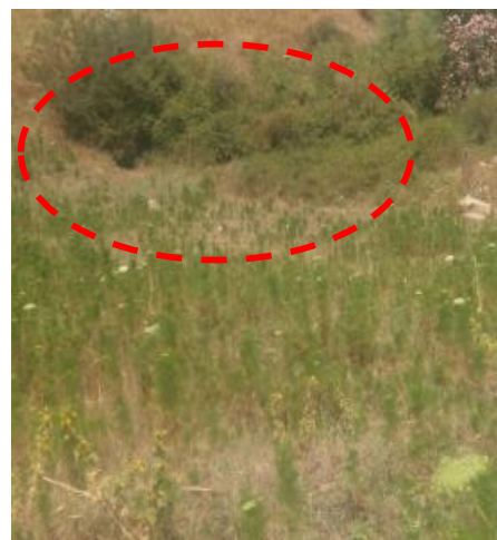
Figure 1.12: Végétation arbustive sur le talus aval
