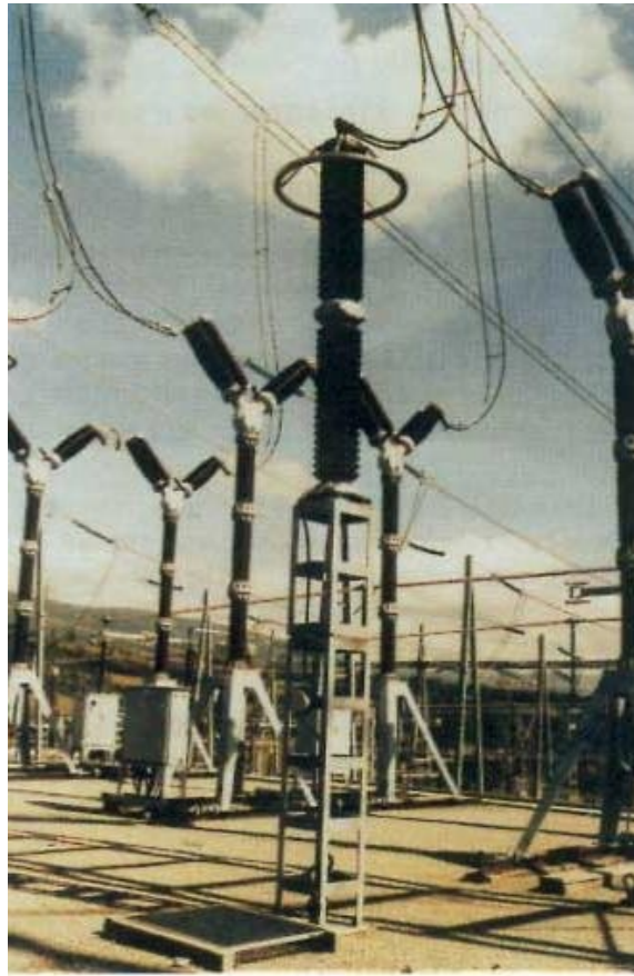
Fig. III.7- exemple d'un parafoudre à oxyde de zinc (ZnO).
