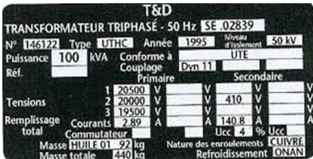
Figure II.5- Exemple d'une plaque signalétique d'un transformateur de puissance.
