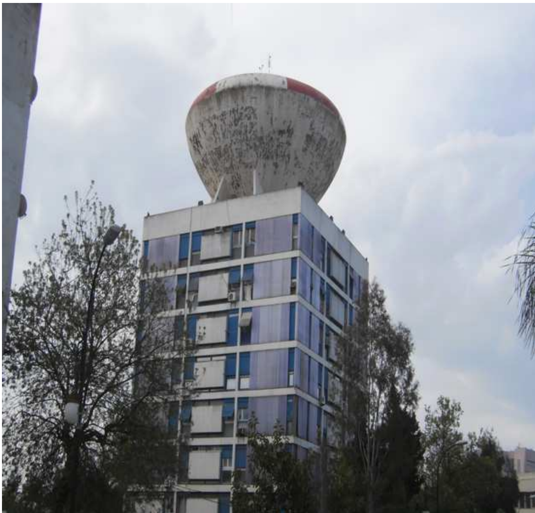
Figure 3.2 : Vue générale du projet.
