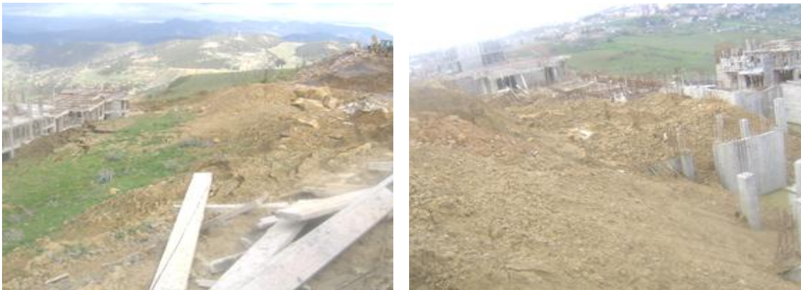
Figure II. 48 : Glissements de terrains, zone des 400 logements de l'OPGI, (Médéa).
