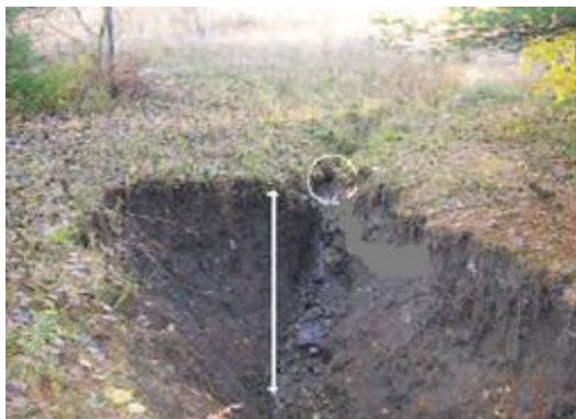
Concentration d'eau (ravinement).
