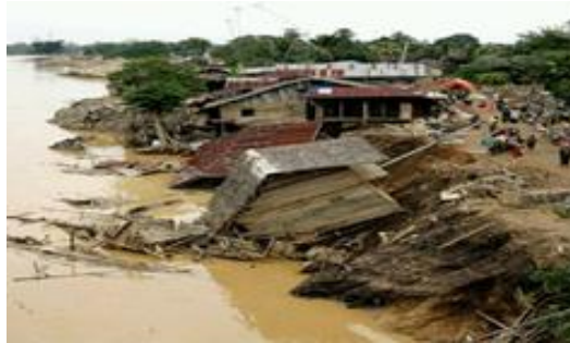
Glissement dû à la déforestation (Indonésie).
