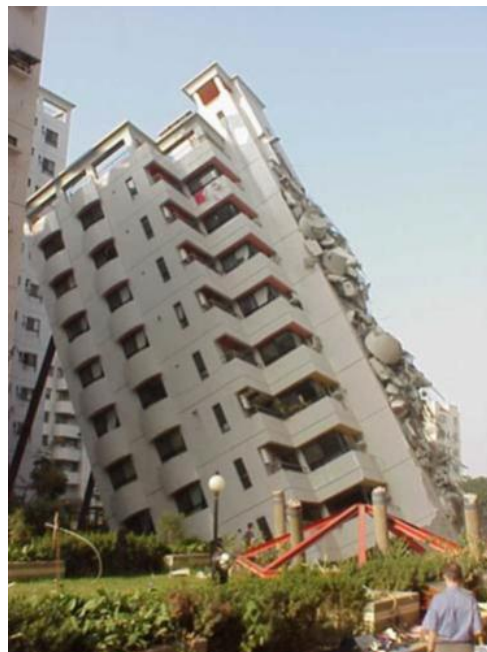
Figure II. 29 : Basculement d'un immeuble sur radier (séisme de Taiwan, 1999).
