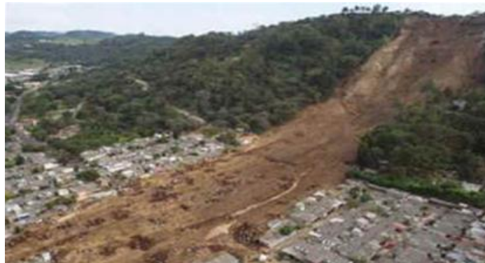
Figure II. 21 : Glissement de terrain lors du séisme de Santa Tecla, (Salvador).
