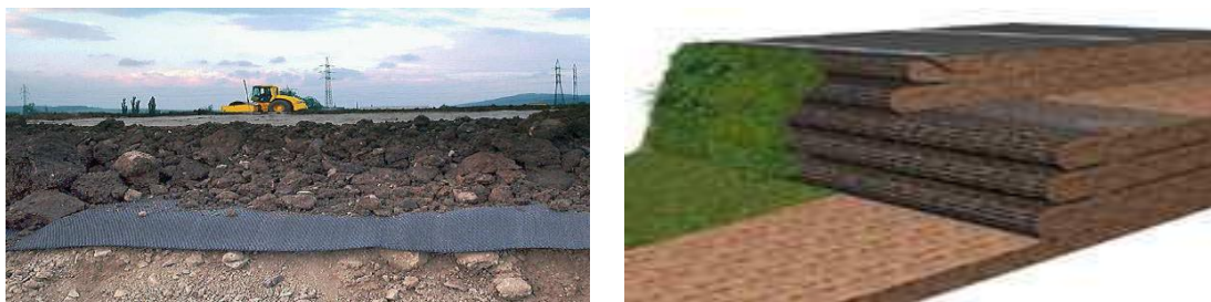
Figure I.16 : Mise en place de géosynthétiques, (Nguyen 2008).
