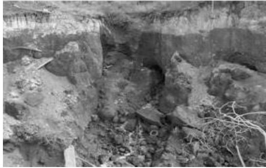
Figure I.12 : Phénomène de ravinement.
