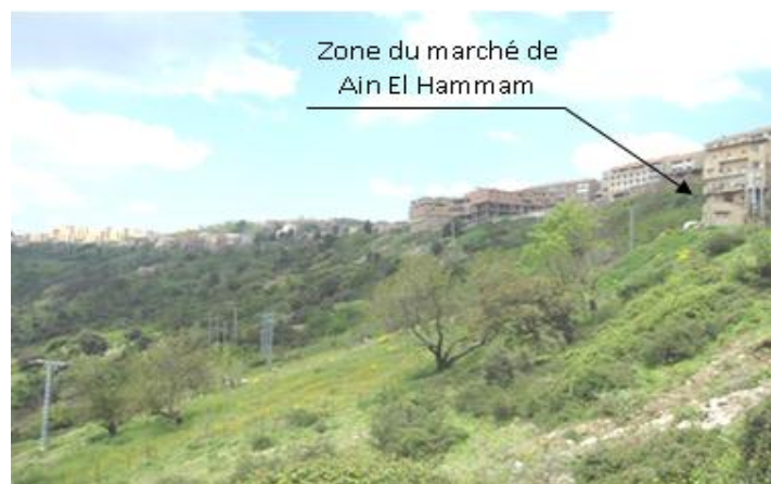
Figure II. 33 : Zone du marché d'Ain-El-Hammam (instable).
