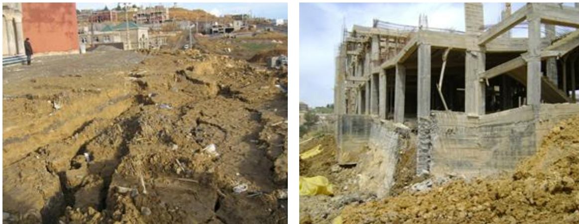
Figure II. 47 : Glissement de terrains, zone du nouveau lycée, (Médéa).
