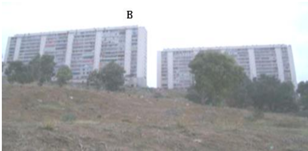
Figure II. 39 : Immeubles du site Ciloc affecté par le glissement, (au pied du bâtiment B).
