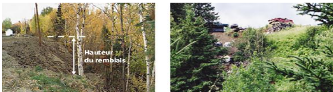
Remblai en sommet du talus.
