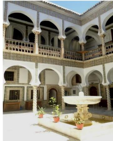
**Galerie:** Dans la maison traditionnelle la galerie en plus de son rôle d'abri contre les intempéries, a un rôle de desserte des appartements d'étage. Elle se développe sur les quatre côtés de la cour, d'où le système de quatre pans d'arcades.
