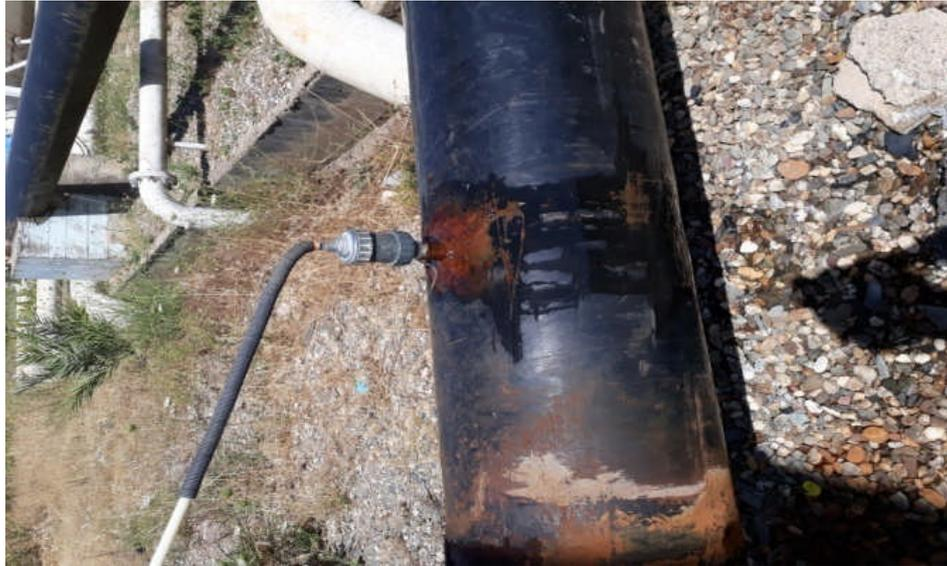
**Figure 10** : Deuxième injection de l'hypochlorite de sodium.
