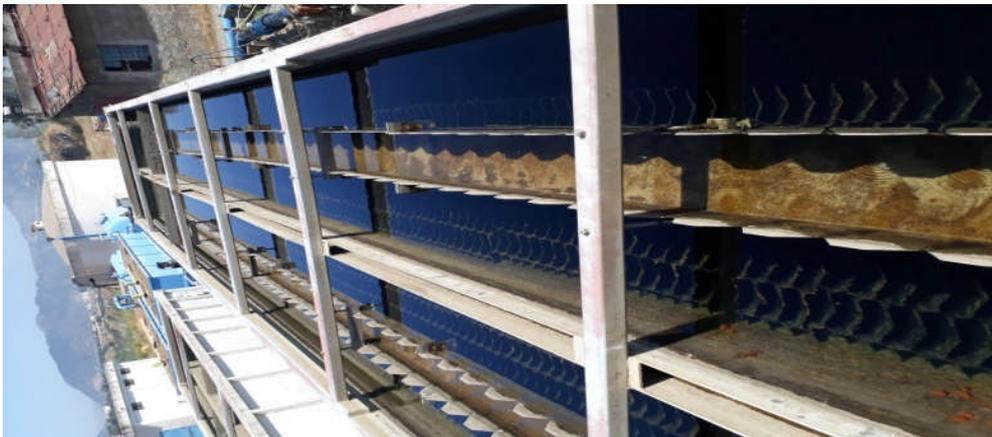
**Figure 7 :** Photo des décanteurs lamellaires.
