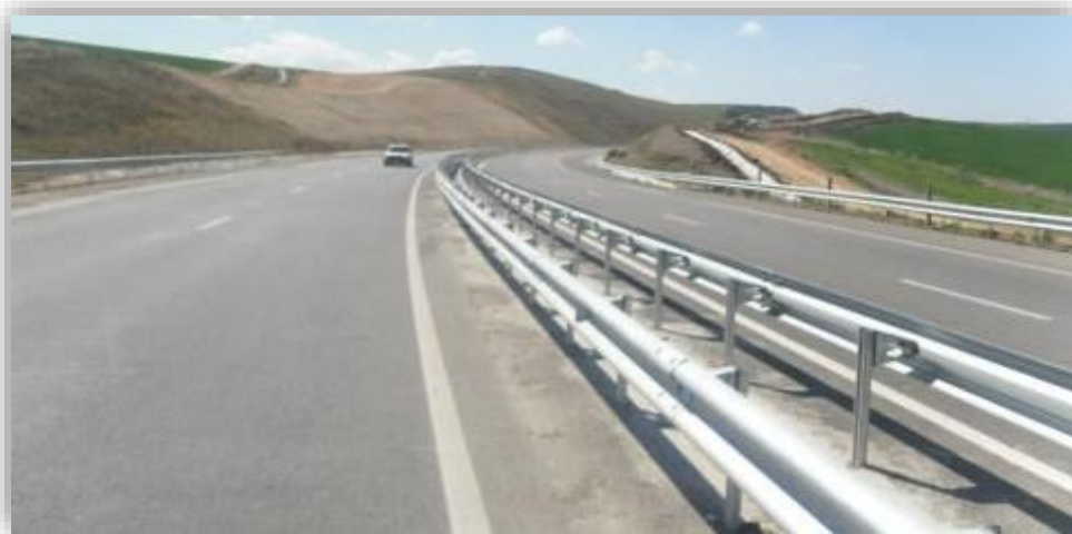
Figure VIII-3 : Glissières métalliques au TPC, et sur accotement.
