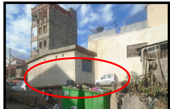
Fig.113.déchets dans la cité Zraba source : auteur
