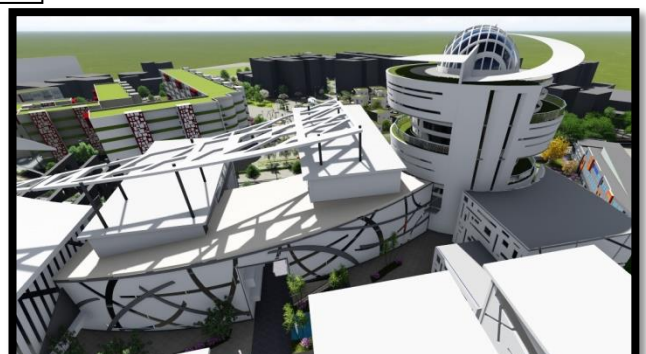
Fig.229. vue sur la façade intérieure Source : auteurs
