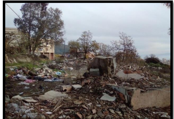
Fig.22.démolition des bidonvilles source: Auteur
