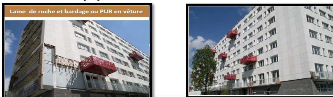
Fig.131.132.. opérations de réhabilitation de logements source : http://semvr.fr/projet/quartierdunouveaumons/
