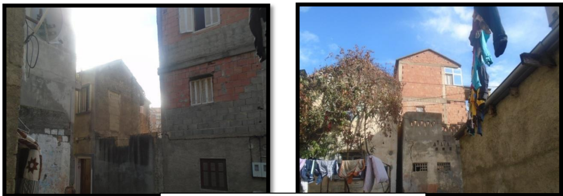
Fig.51.52. cité Zraba. Source : auteur
