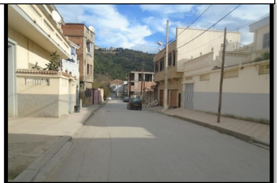
Fig.41.maisons du lotissement source : auteur
