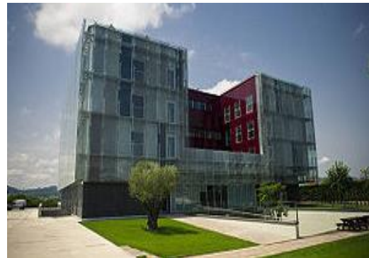
Fig.211. Façade principale du centre Masia
