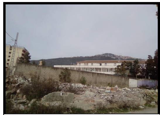
Fig.32. vue depuis le côté sud source : auteur
