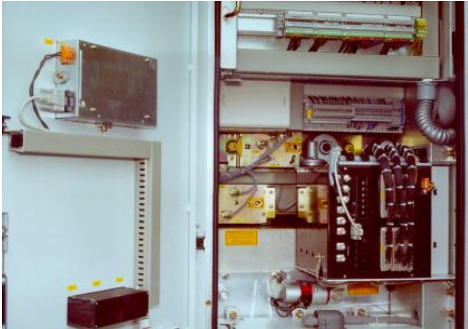
Figure IV-4-Montage de l'unité centrale dans le compartiment BT de l'IHM sur la porte
