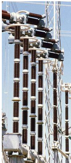
Figure II-7: disjoncteur à air comprimé
