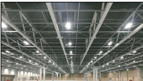
Figure 238 : structure en treillis
