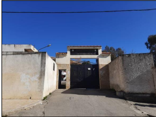
Figure 148 : Photo de l'entrée de CEM Hammoutene Source : auteurs
