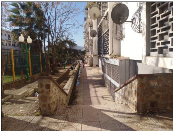
Figure 58 : photo sur Le passage piéton de la cité CADI Source : auteurs
