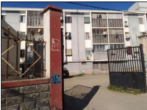
Figure 134 : photo de la cité avant les interventions Source : auteurs
