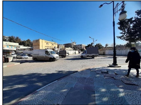
Figure 38 : photo de la rue KESRI Amar Source : auteurs
