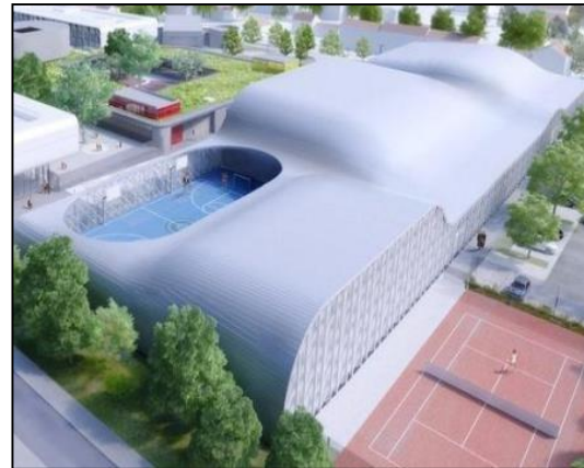
Figure 186 : Complexe sportif du campus trivaux Garenne Clamart
