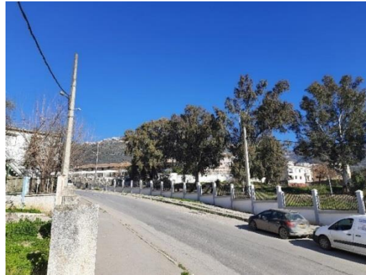
Figure 111 : Rue KESRI avant les interventions Source : auteurs
