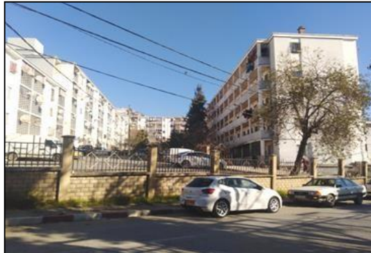
Figure 132 : photo de la cité avant les interventions Source : auteurs
