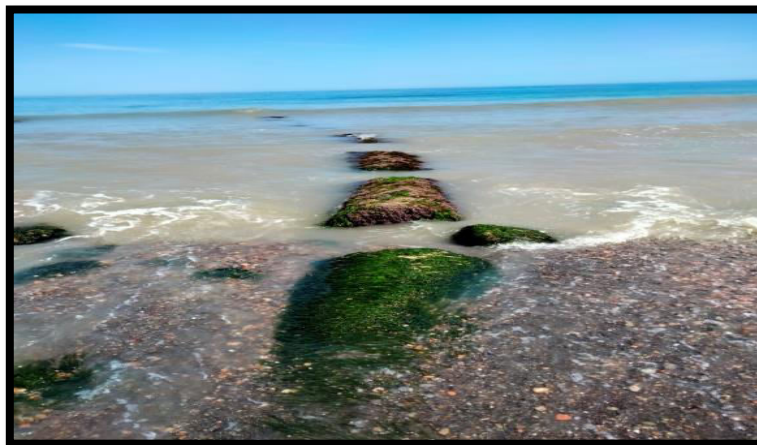
Figure III.5: Prise d'eau de mer à la plage TASSALAST.
