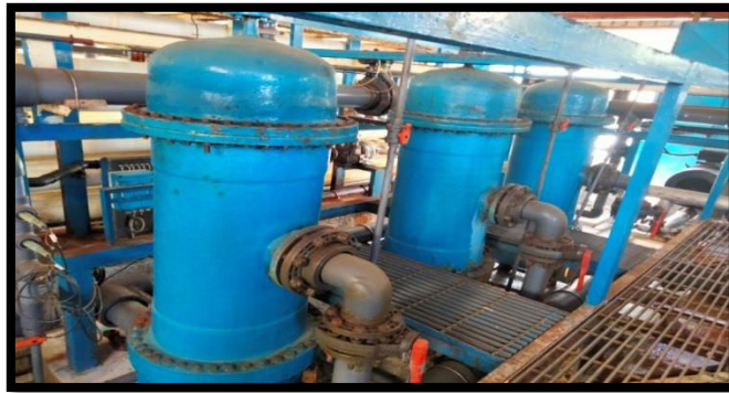
Figure III.13: Les micros filtres (filtres à cartouches).
