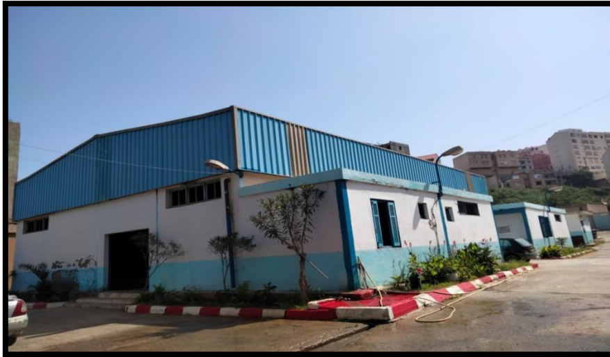
Figure III.2 : Vue générale de la station de dessalement de Tizirt.
